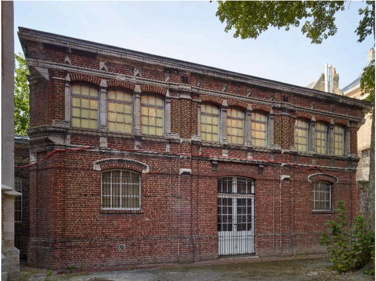
Vue général côté sud.
