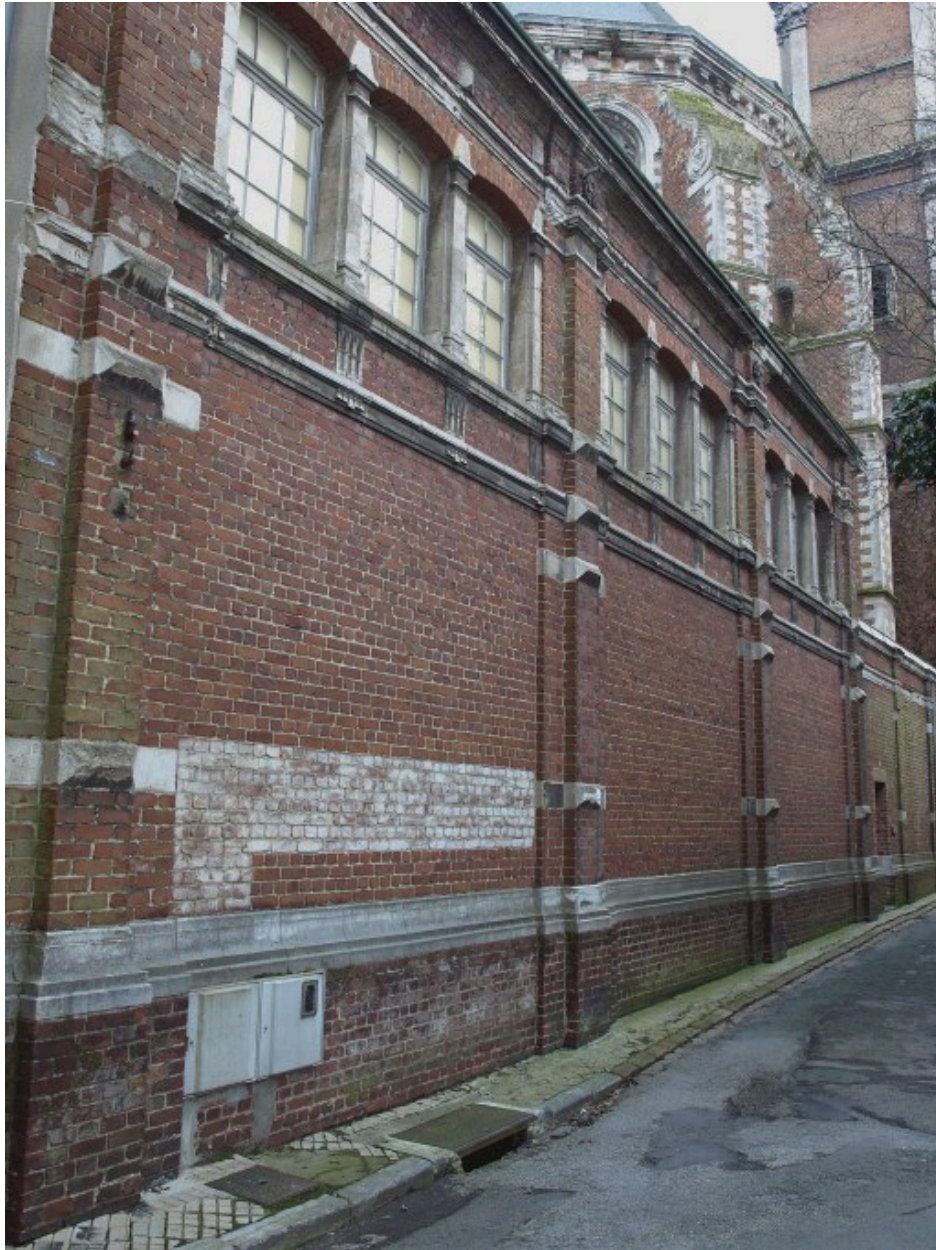
Vue générale depuis la rue au Vent
