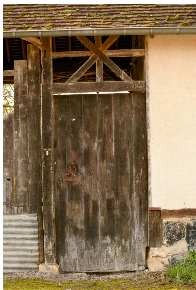
Détail : entrée piétonne et imposte ajourée, n°4 rue Mariette. Phot. Marc Kérignard IVR32_20236000018NUCA
