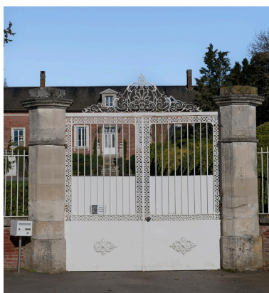
Portail, n°21 rue de l'Église, vue prise depuis le sud. Phot. Marc Kérignard IVR32_20236000009NUCA
