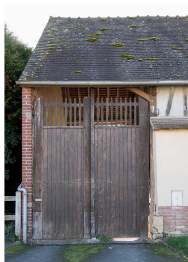
Entrée charretière, n°32 rue de l'Église, vue depuis le nord. Phot. Marc Kérignard IVR32_20236000005NUCA
