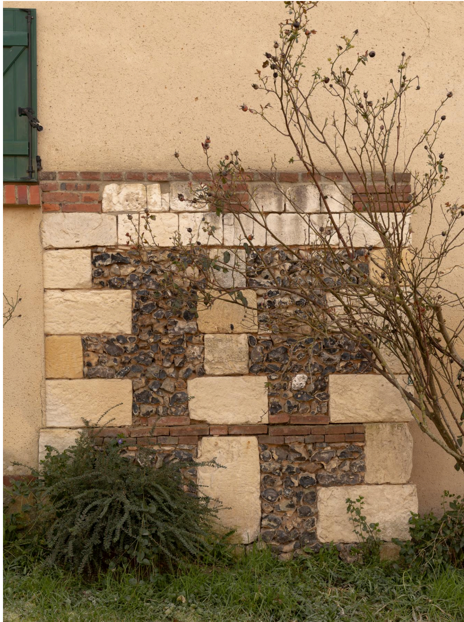
Détail de maçonnerie (n°2 rue Mariette) : chaînage en pierre de taille et moellon de silex.
