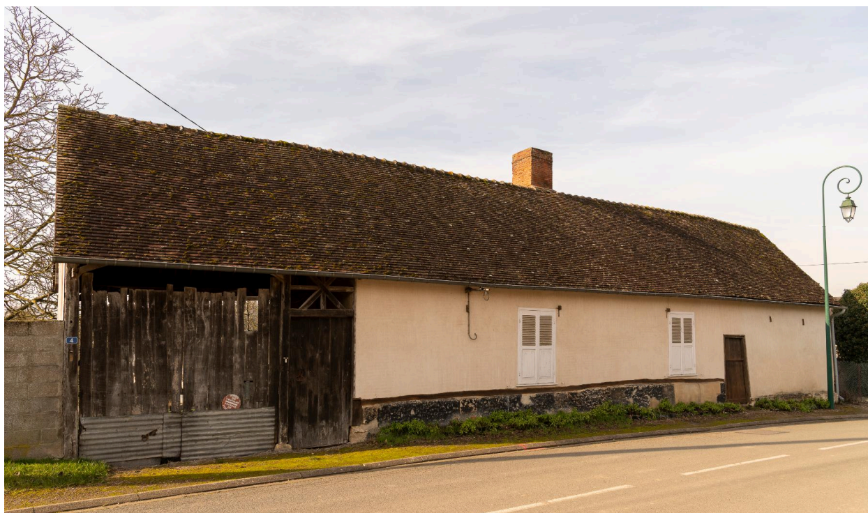
Logis sur rue, n°4 rue Mariette, vue prise depuis le nord-est.
