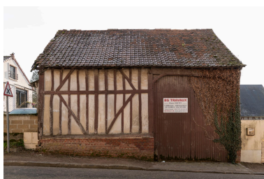
Grange sur rue, n°5 bis rue de la Chaussée, vue depuis le nord-ouest. Phot. Marc Kérignard IVR32_20236000015NUCA
