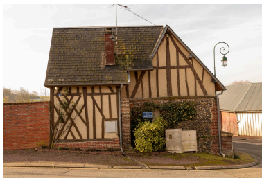
Logis, n°2 rue Mariette, vue prise depuis le nord-est. Phot. Marc Kérignard IVR32_20236000016NUCA
