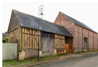
Grange sur rue, n°35 rue de la Chaussée, vue prise depuis le nord.
