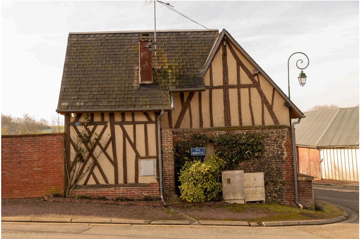
Logis, n°2 rue Mariette, vue prise depuis le nord-est.
