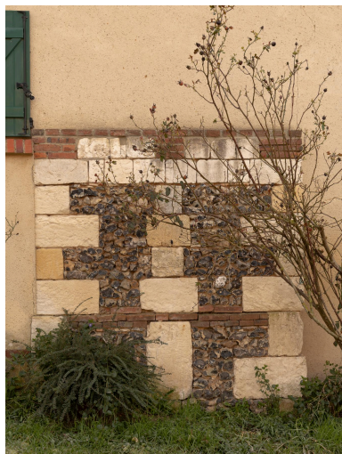
Détail de maçonnerie (n°2 rue Mariette) : chaînage en pierre de taille et moellon de silex. Phot. Marc Kérignard IVR32_20236000014NUCA
