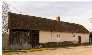
Logis sur rue, n°4 rue Mariette, vue prise depuis le nord-est. Phot. Marc Kérignard IVR32_20236000017NUCA
