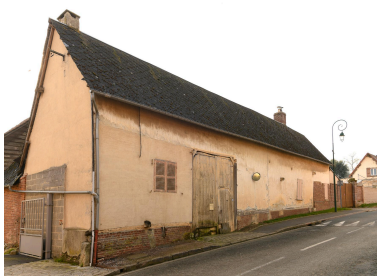
Grange avec atelier sur rue (?), n°31 rue de la Chaussée, vue prise depuis le nord.
