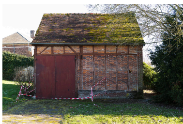
Grange, rue Mariette, vue depuis l'ouest. Phot. Marc Kérignard IVR32_20236000010NUCA
