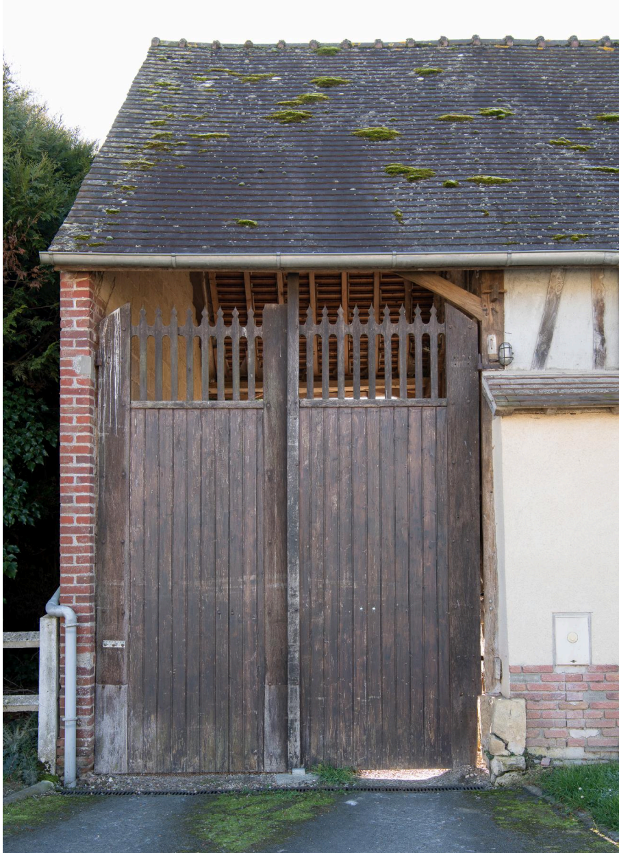
Entrée charretière, n°32 rue de l'Église, vue depuis le nord.
