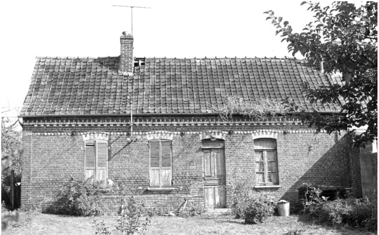
Façade antérieure, sur rue.
