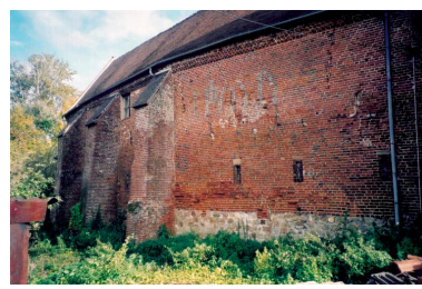
Détail d'un corps ancien de la maison d'habitation faisant apparaître des symboles figurés dans le mur. Phot. Gilles-Henri Bailly IVR22_20158005463NUCA
