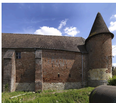
Détail du mur de brique conservé de l'ancien château. Phot. Thierry Lefébure IVR22_20158000543NUC2A
