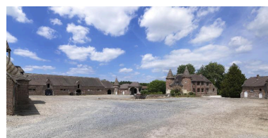
Vue d'ensemble de la ferme et du château de Canisy. Phot. Thierry Lefébure IVR22_20158000540NUC2AQ
