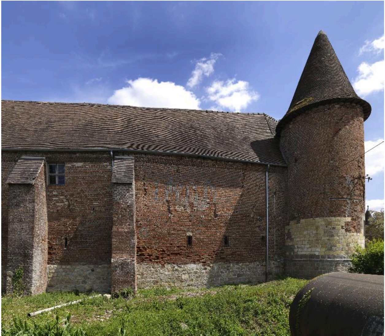
Détail du mur de brique conservé de l'ancien château.
