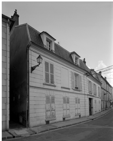
Vue générale depuis la rue. Phot. Thierry Lefébure IVR22_19940200748V
