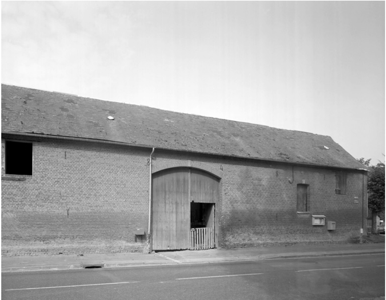
Partie orientale de la grange sur rue (date 1848 en fers d'ancrage).
