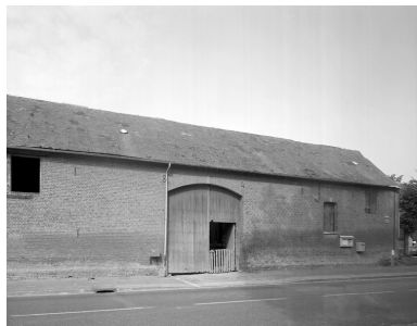
Partie orientale de la grange sur rue (date 1848 en fers d'ancrage). Phot. Irwin Leullier IVR22_19978000702V
