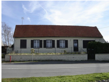
Vue générale du logis.
