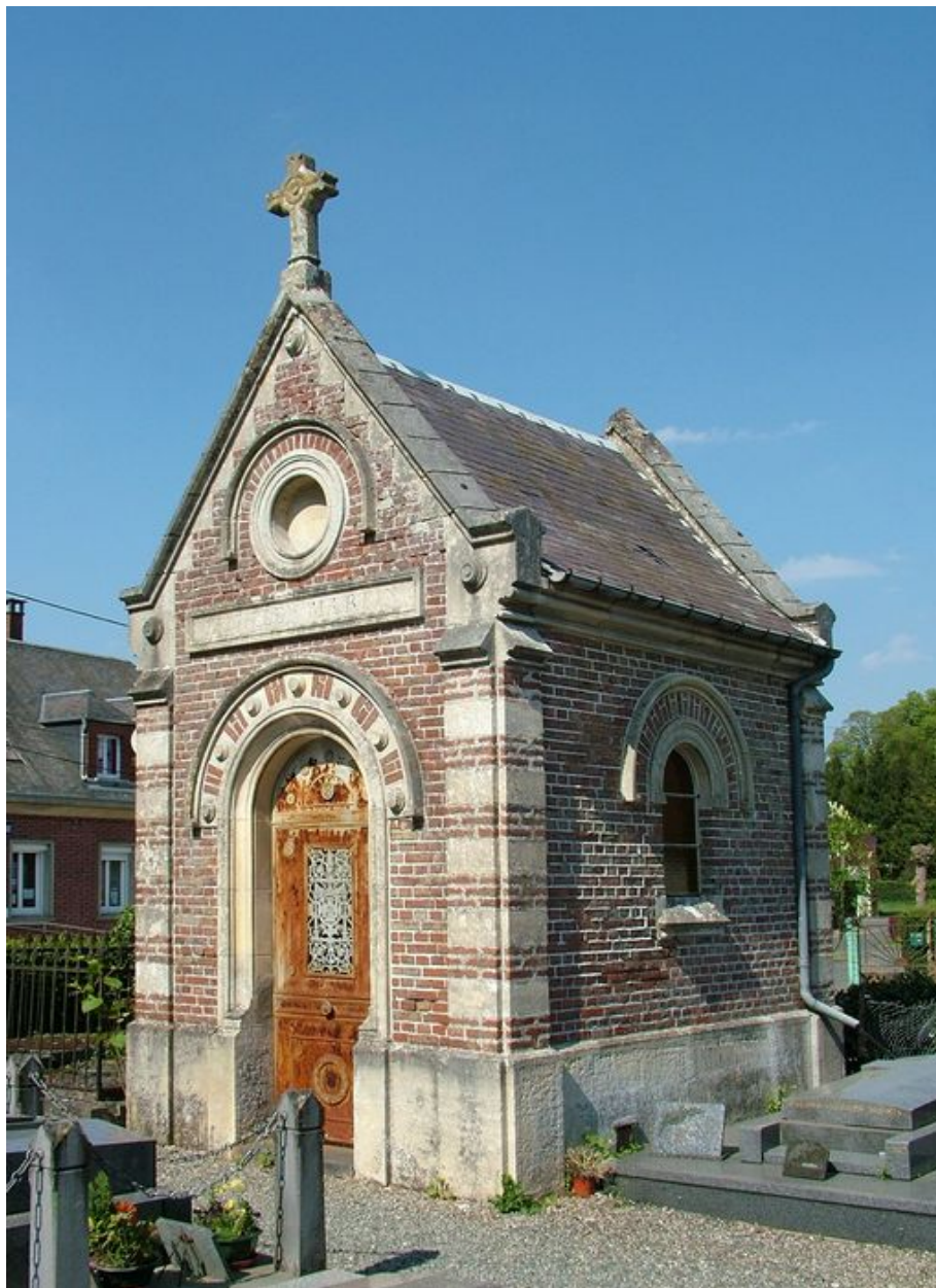
Tombeau (chapelle) de la famille Martin, fin du 19e siècle, avec porte en fonte portant la signature : LAMARRE/RUE DES BOUTEILLES/AMIENS.
