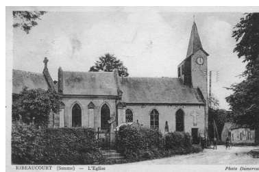
Vue générale depuis le nord, années 1930 (coll. part.) Phot. Monnehay-Vulliet Marie-Laure IVR22_20118000155NUCA
