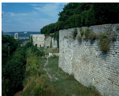
Vue générale des remparts, côté sud.
