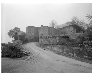
La porte saint-Jean, vue de la rue du Château.
