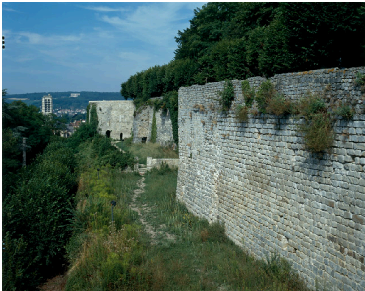
Vue générale des remparts, côté sud.
