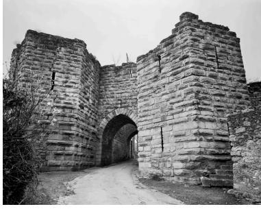
La porte Saint-Jean, vue rapprochée. Phot. Patrick Glotain IVR22_19930200517V
