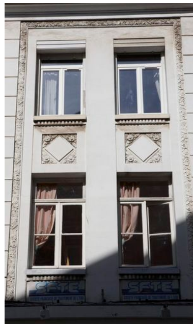
Encadrement, allèges sculptées et appuis de baies aux motifs et aux formes Art déco. Phot. Pierre Thibaut IVR31_20096200196NUCA
