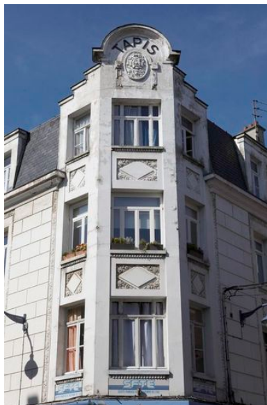
Angle aux formes et aux motifs Art déco. Phot. Pierre Thibaut IVR31_20096200198NUCA
