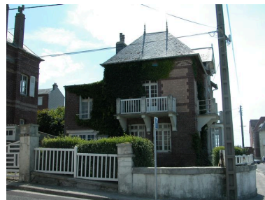
Élévation latérale gauche. Phot. Elisabeth Justome IVR22_20048001693NUCA
