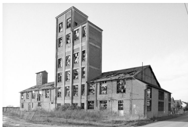
Vue d'ensemble de la râperie depuis le sud. Phot. Francis Dubuc IVR22_19908001452Z
