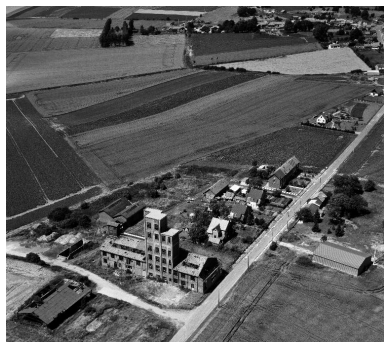
Vue aérienne, flanc sud-est. Phot. Phot'R IVR22_19888001260P
