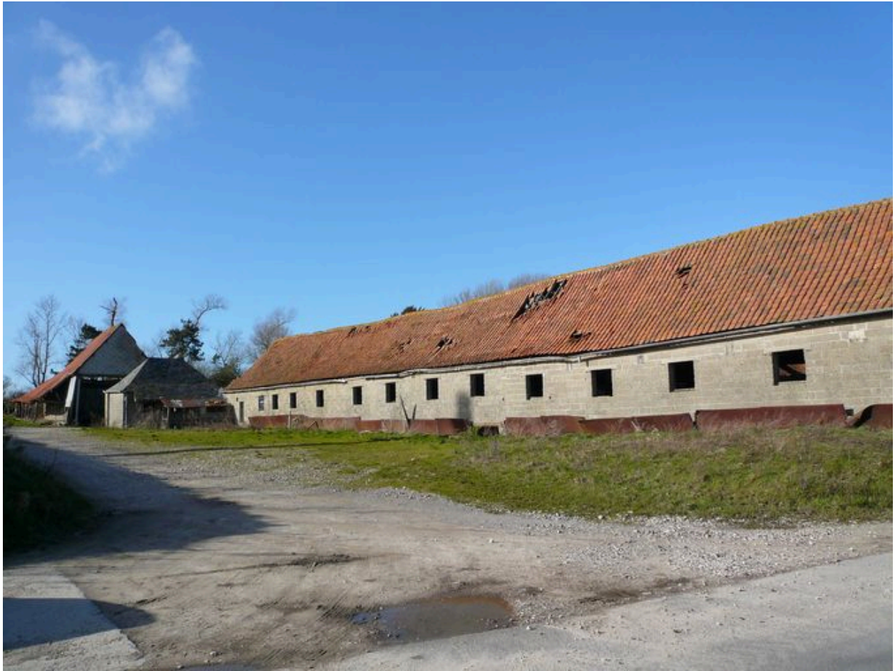
Vue des étables au sud de la cour.
