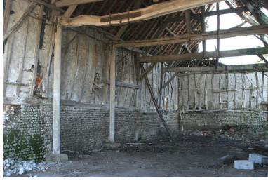
Vue intérieure de la grange. Phot. Irwin Leullier IVR22_20078000146NUC2A
