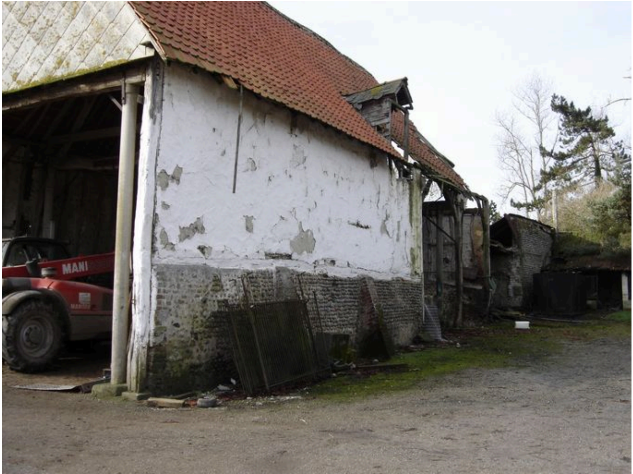
Vue du côté nord de la grange.
