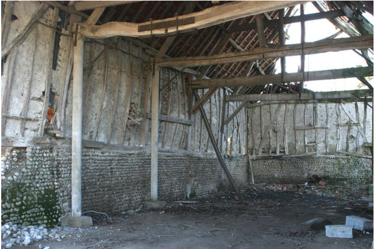
Vue intérieure de la grange.
