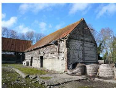
Vue des écuries au nord. Phot. Inès Guérin IVR22_20078005435NUCA
