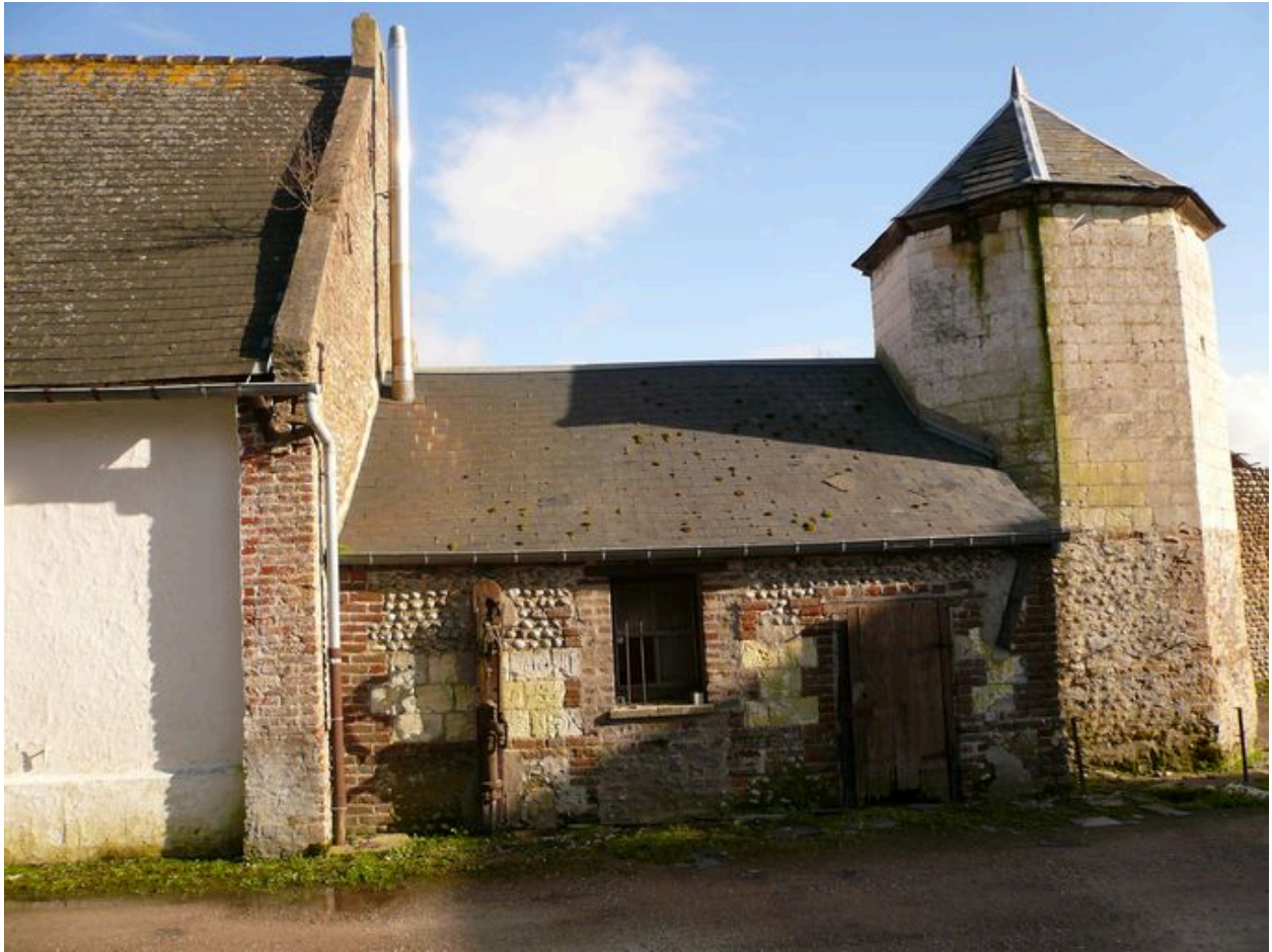
Vue détaillée de la remise depuis l'ouest flquant le logis.
