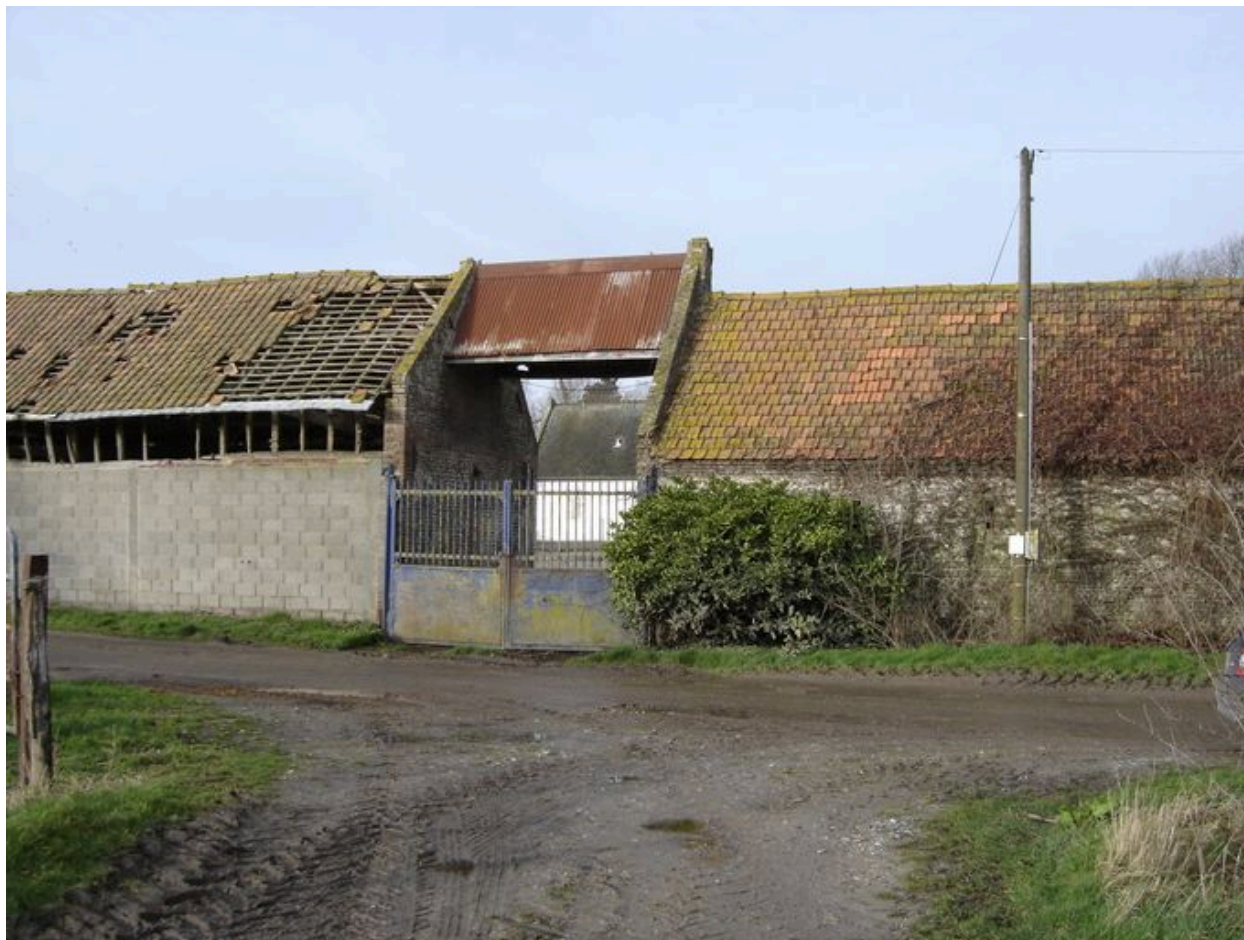
Détail du corps de passage servant d'entrée à la cour, à l' est de celle-ci.
