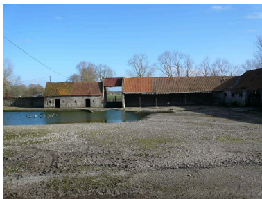
Vue depuis le logis du côté est de la cour. Phot. Inès Guérin IVR22_20078005429NUCA
