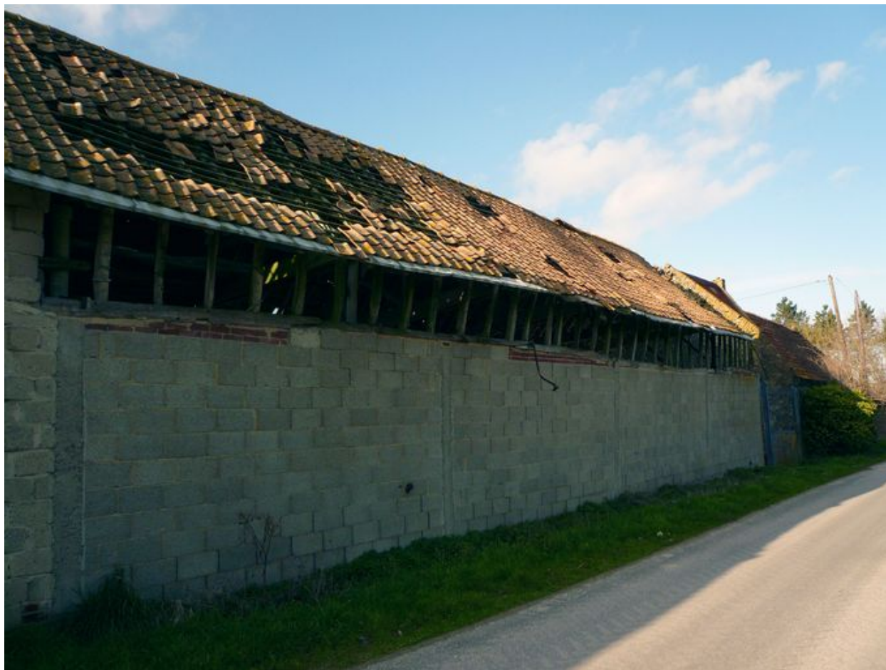
Vue depuis la rue des abris à machines situés à l'est de la cour.
