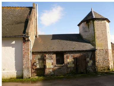
Vue détaillée de la remise depuis l'ouest flanquant le logis. Phot. Inès Guérin IVR22_20078005425NUCA
