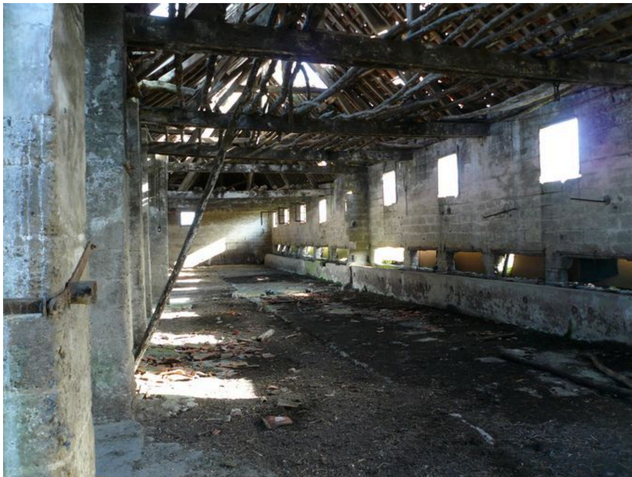
Vue intérieure des étables.
