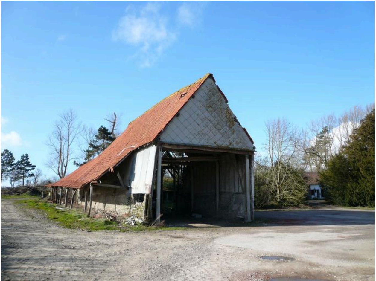
Vue de la grange depuis le sud-ouest.
