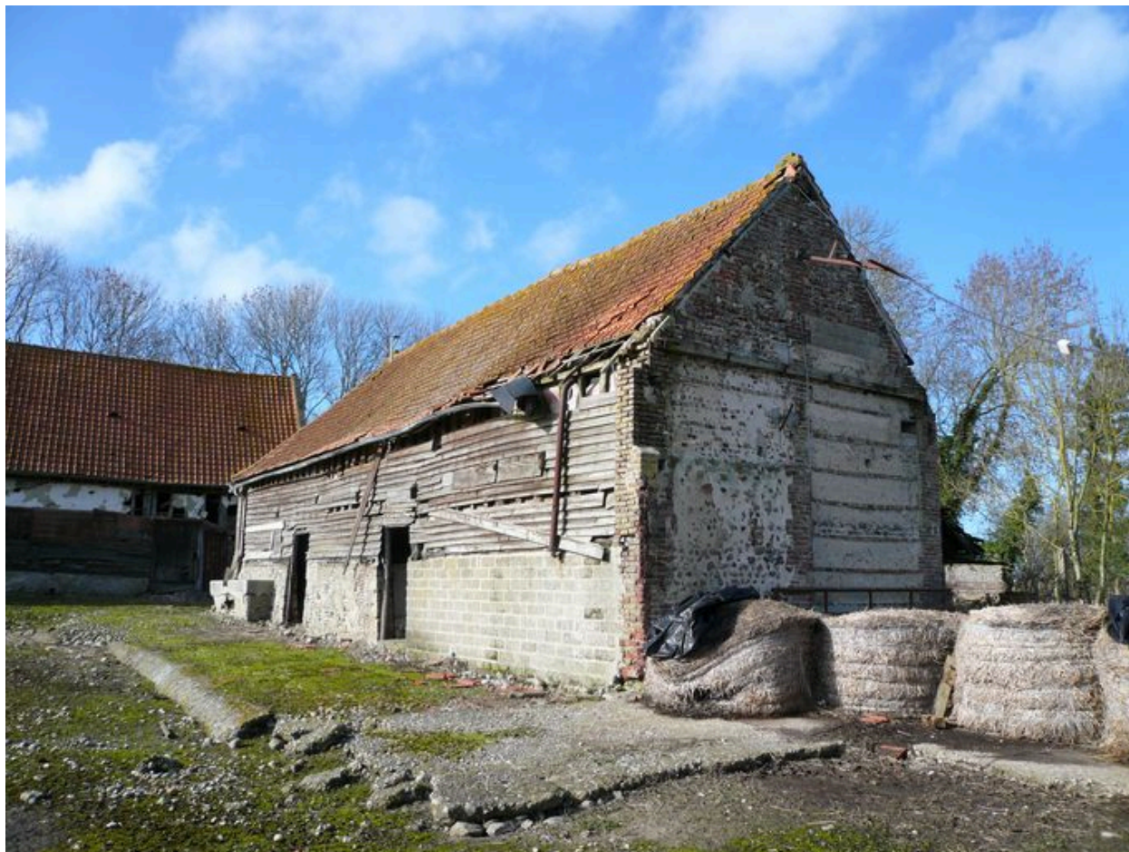
Vue des écuries au nord.
