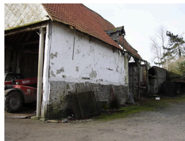
Vue du côté nord de la grange. Phot. Catherine Fourmond IVR22_20058001430NUCA
