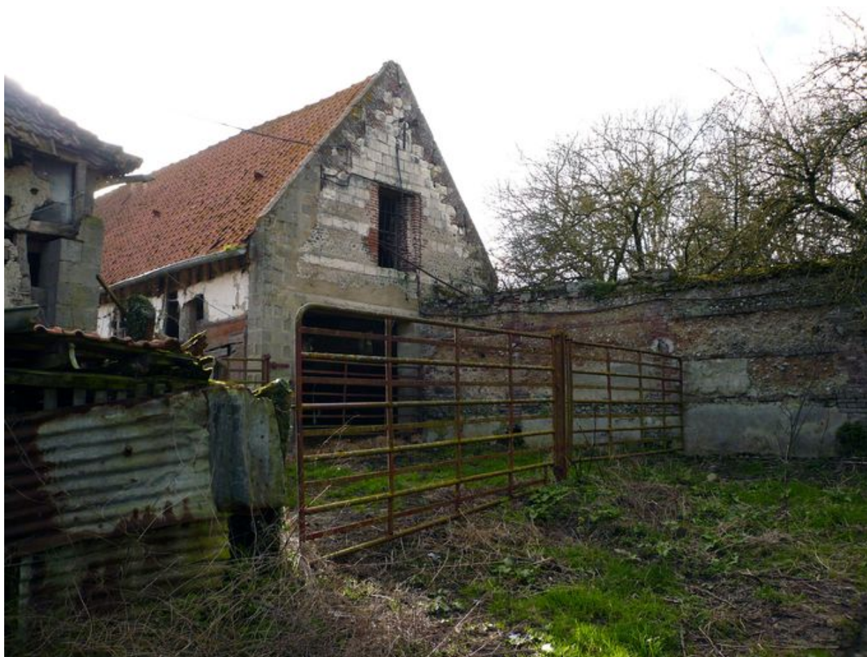
Vue du pignon nord des écuries situées dans le prolongement du logis.
