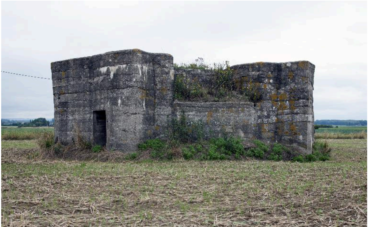
Vue de trois-quarts vers l'ouest. Entrée est
