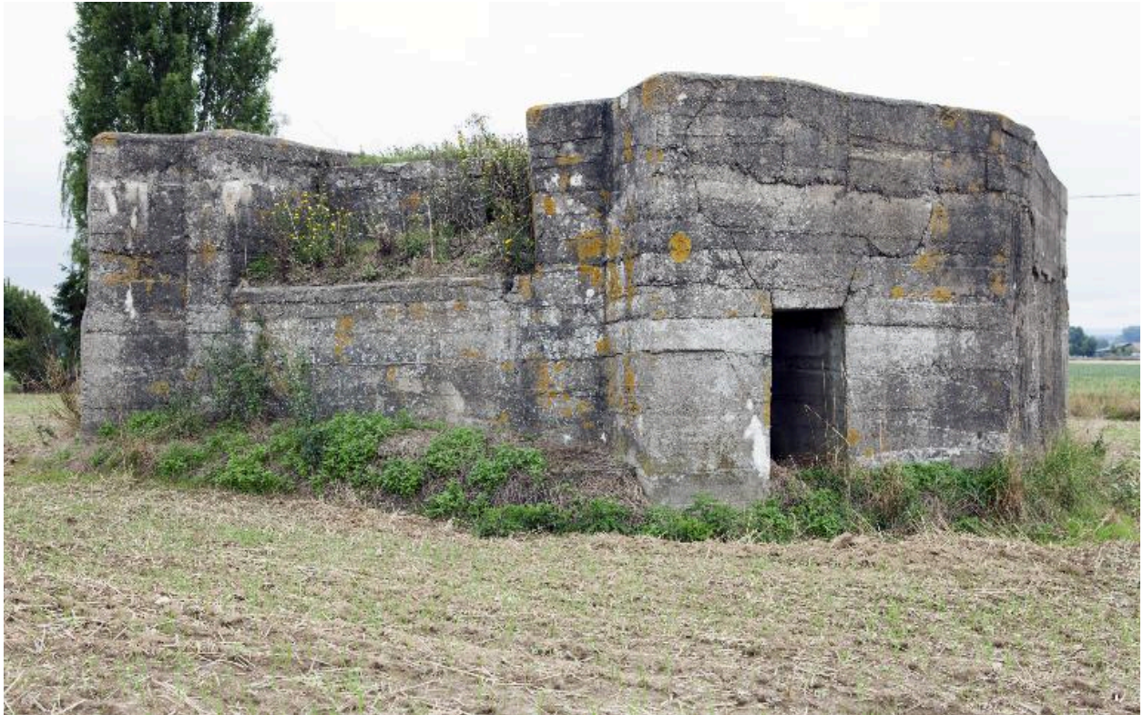
Vue de trois-quarts avant, vers le sud
