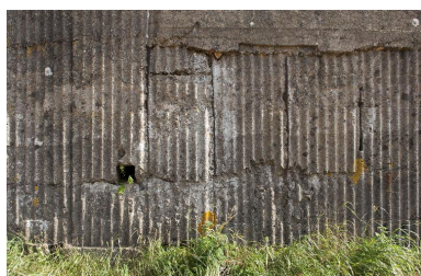
Elévation sud-ouest, détail du coffrage et créneau de fusillade Phot. Jean-Marc Ramette IVR31_20145905156NUCA
