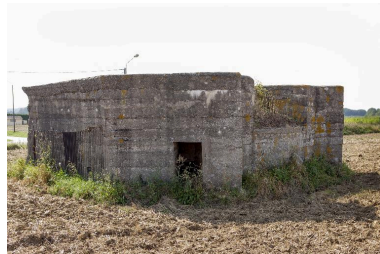
Vue de trois-quarts vers l'ouest. Entrée est Phot. Jean-Marc Ramette IVR31_20145905153NUCA
