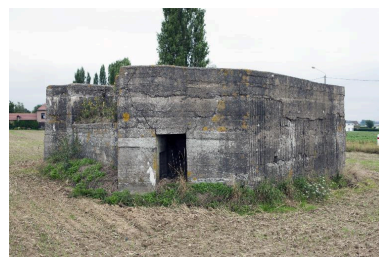
Vue latérale, entrée nord Phot. Pierre Thibaut IVR31_20155901452NUCA
