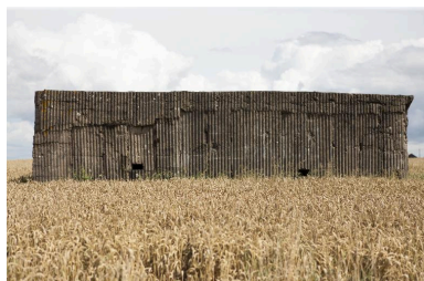
Elévation sud-ouest Phot. Jean-Marc Ramette IVR31_20145905148NUCA
