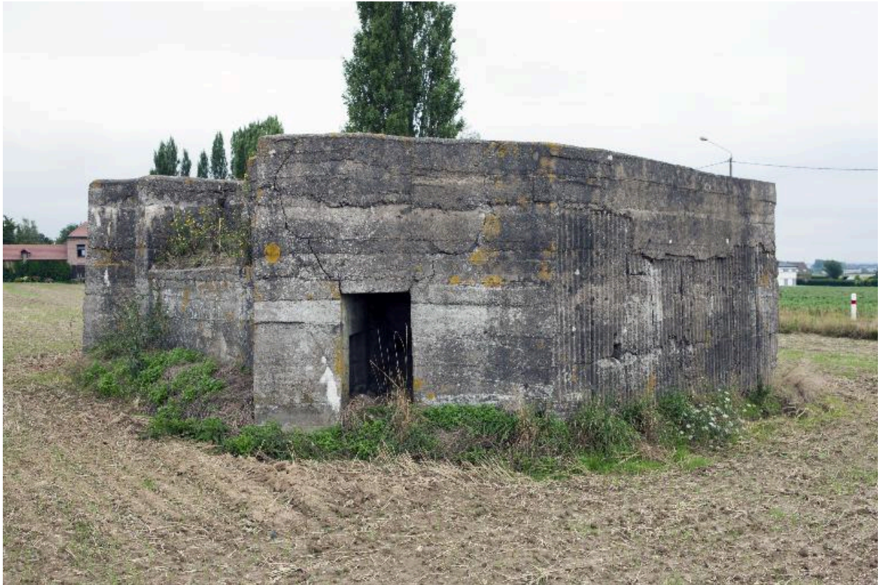
Vue latérale, entrée nord
