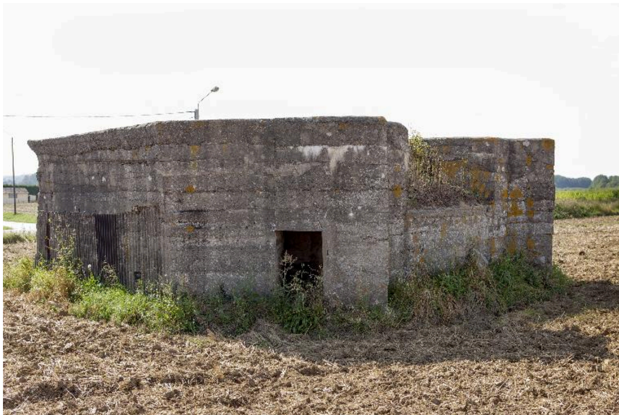
Vue de trois-quarts vers l'ouest. Entrée est
