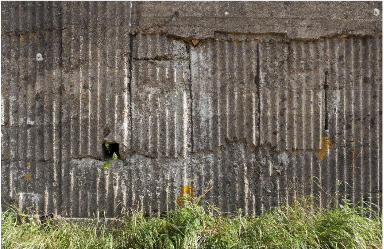
Elévation sud-ouest, détail du coffrage et créneau de fusillade
