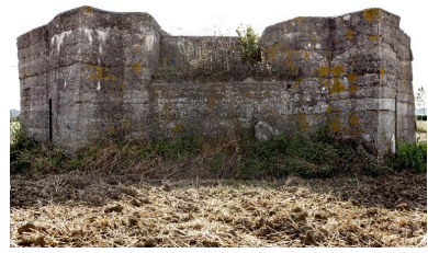
Vue antérieure vers le sud-ouest Phot. Jean-Marc Ramette IVR31_20145905154NUCA
