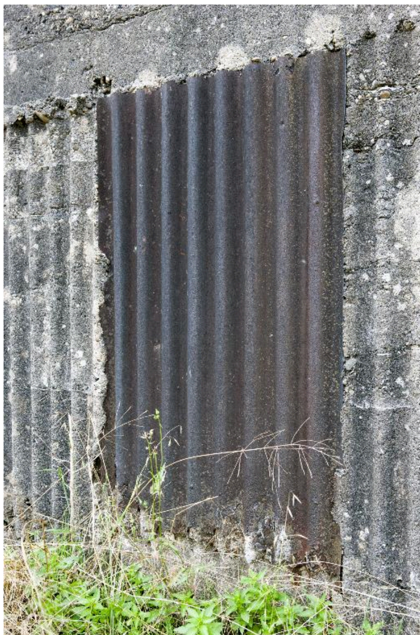
Elévation sud-est. Vestige de coffrage en tôle ondulée
