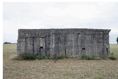
Elévation sud-ouest Phot. Pierre Thibaut IVR31_20155901455NUCA
