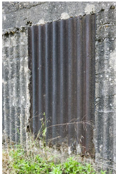
Elévation sud-est. Vestige de coffrage en tôle ondulée Phot. Pierre Thibaut IVR31_20155901454NUCA
