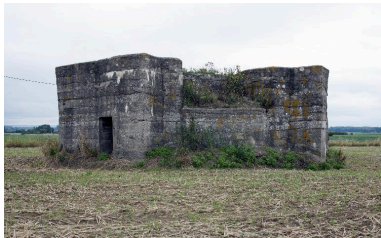
Vue de trois-quarts vers l'ouest. Entrée est Phot. Pierre Thibaut IVR31_20155901450NUCA
