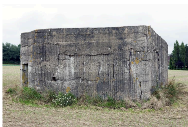
Vue latérale nord Phot. Pierre Thibaut IVR31_20155901453NUCA
