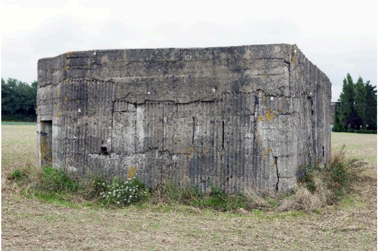
Vue latérale nord
