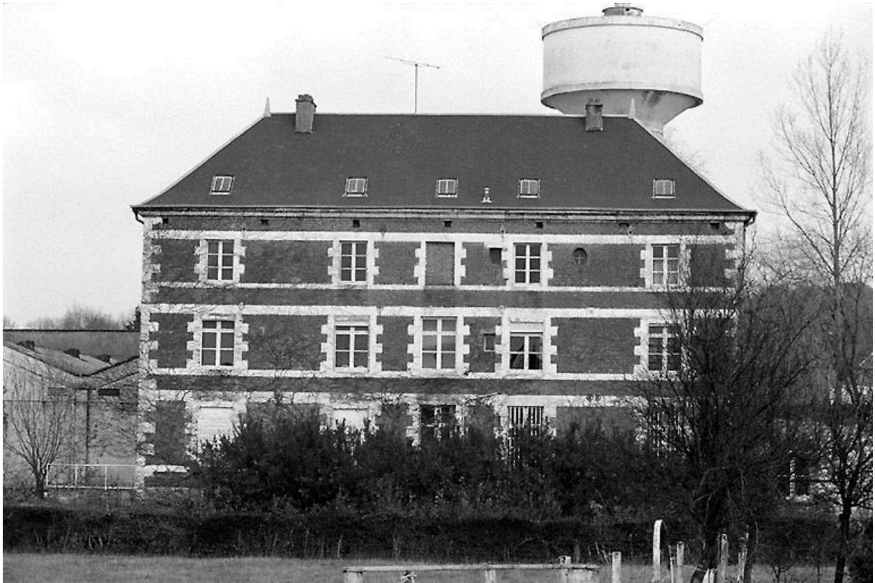
Bâtiment à 4 niveaux de 1825.
