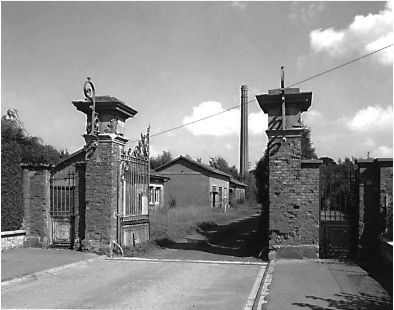
Vue du portail d'entrée sur la rue de Beaumé.
