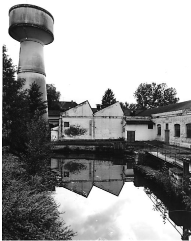
Vue depuis le bassin de retenue, des ateliers de fabrication, avec à gauche le château d'eau, à droite la centrale électrique.
