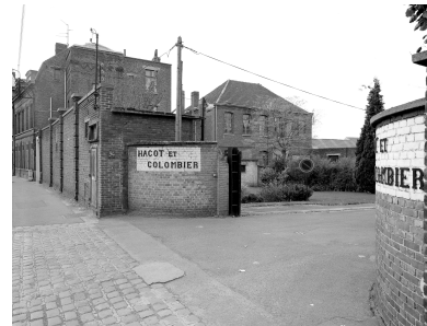
Vue générale depuis la rue, vers l'ouest. Entrée de la filature Hacot et Colombier. Phot. Olivier Marlard IVR31_19905901075V
