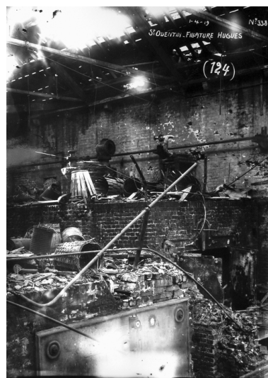
Vue intérieure de la filature en ruine, vers 1919 (AD Aisne). Phot. Pillet Frédéric IVR22_20060205403NUCAB
