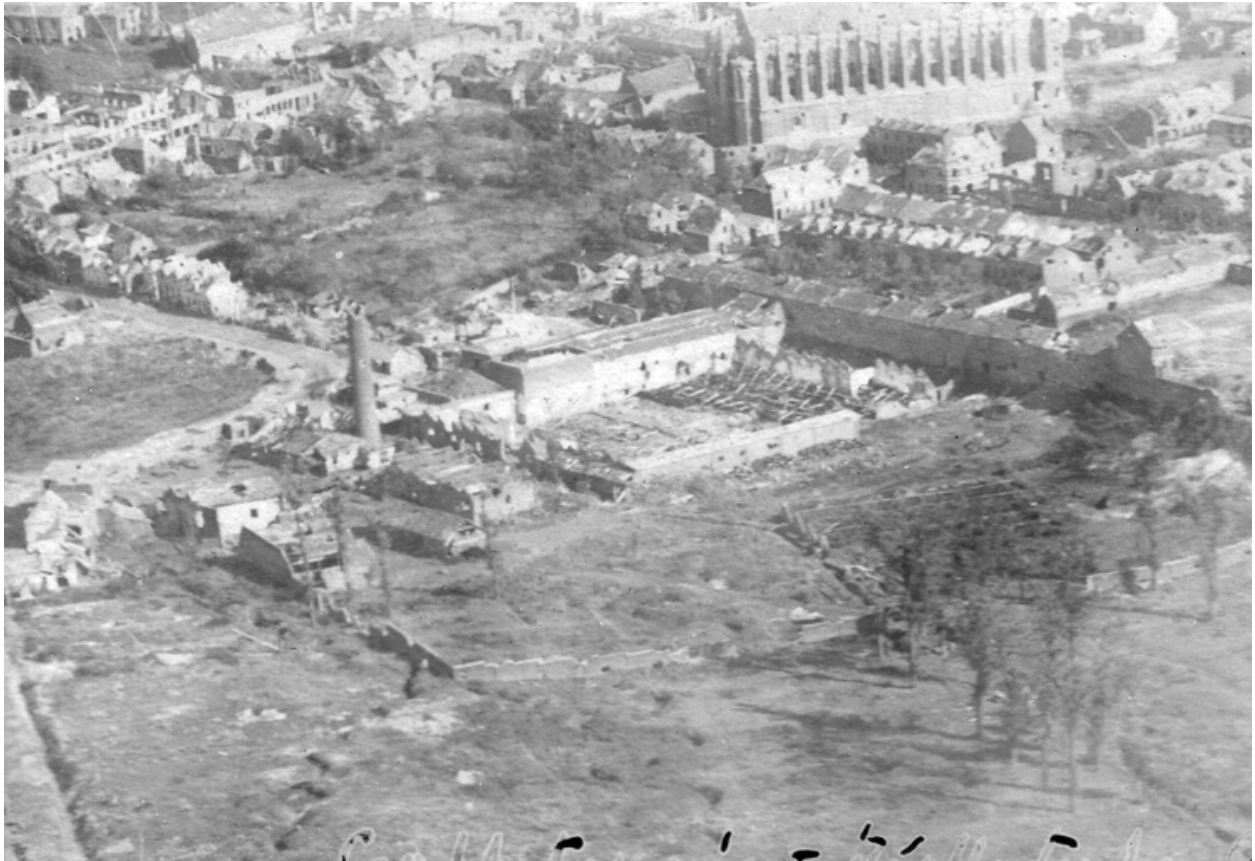
Vue aérienne de la filature, 1918 (AC Saint-Quentin).
