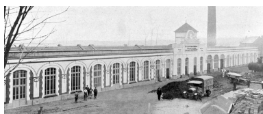
La reconstruction des ateliers en cours d'achèvement, 1920 (Le Monde Illustré). Phot. Pillet Frédéric IVR22_20060205406NUCAB
