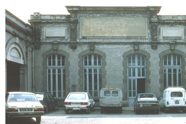
Façade sur cour, entrée des ateliers, 1983 (BM Saint-Quentin). Phot. Pillet Frédéric, Autr. Catherine Chaplain IVR22_20070205029NUCA
