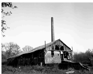
La cheminée d'usine et l'angle sud ouest du four industriel type Hoffmann. Phot. Franck Bürjes IVR22_19986000261X
