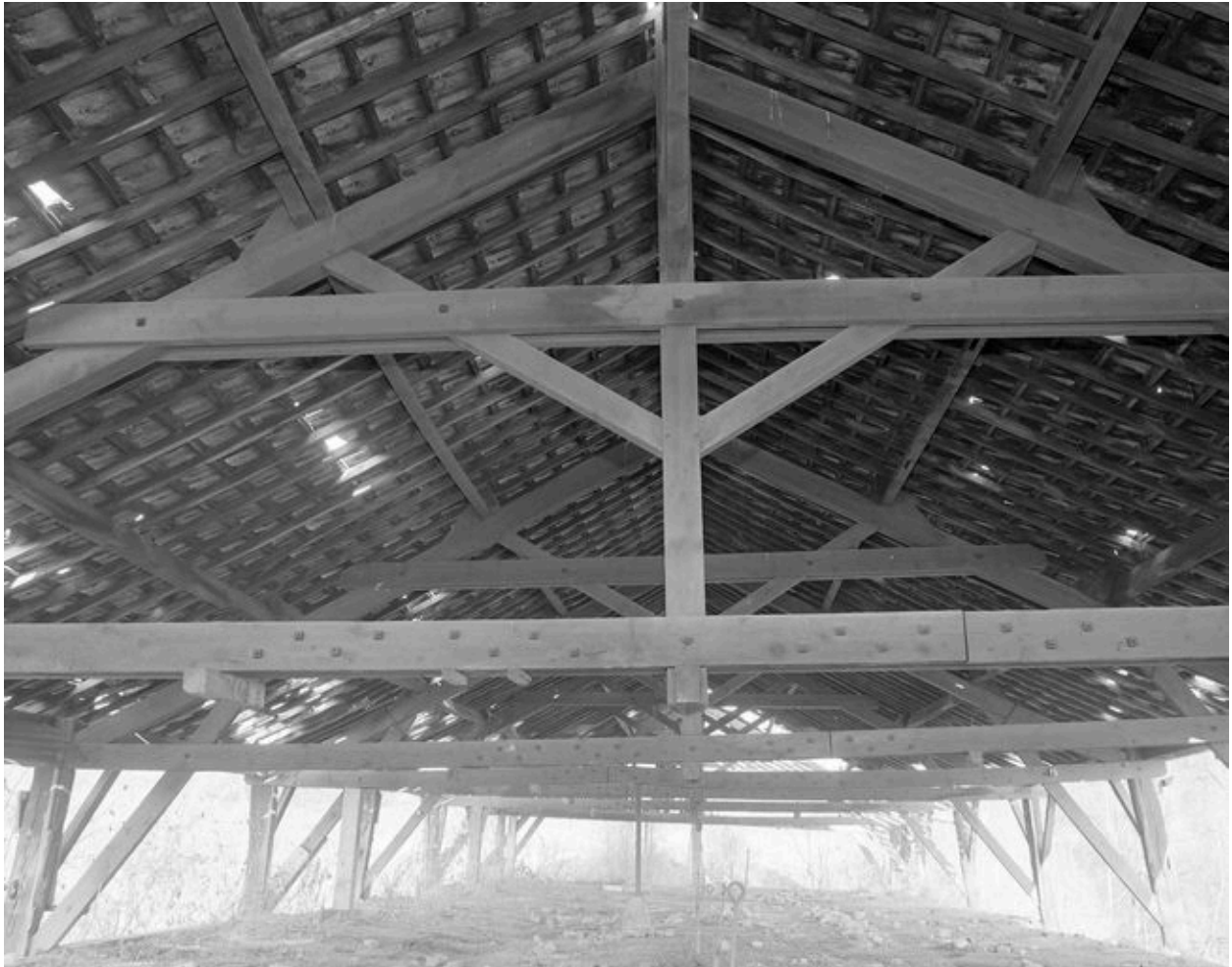
Charpente du bâtiment abritant le four industriel de cuisson.
