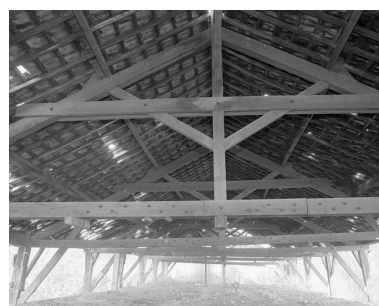
Charpente du bâtiment abritant le four industriel de cuisson. Phot. Franck Bürjes IVR22_19986000280X
