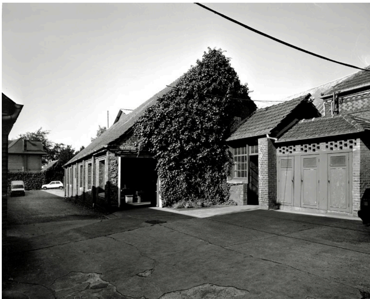
Vue des ateliers, côté cour, en 1988.
