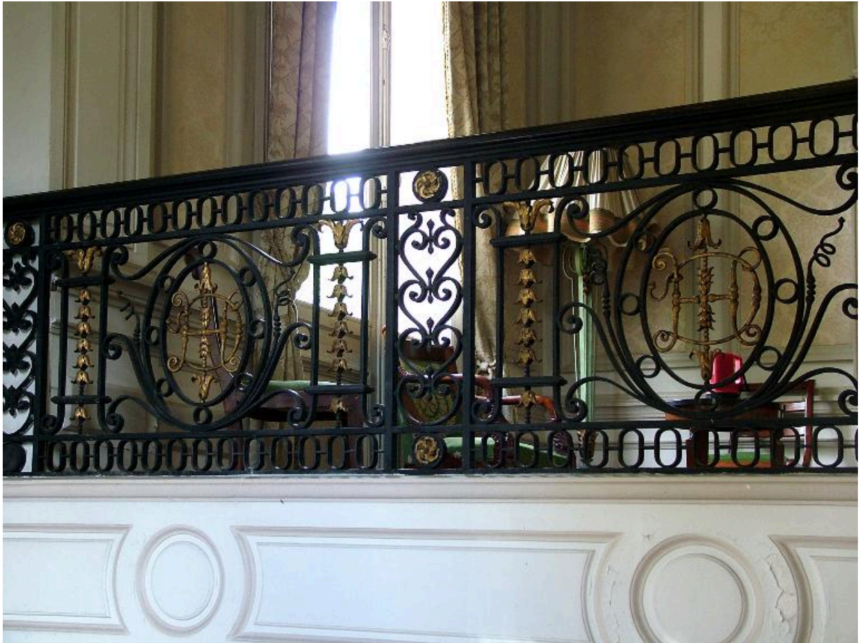
Escalier, détail de la rampe en fer forgé aux initiales entrelacées H et C (Hordequin et Carette ).
