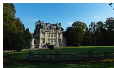
Façade arrière du logis depuis la balustrade. Phot. Marie-Laure Monnehay-Vulliet IVR22_20128001360NUC2A
