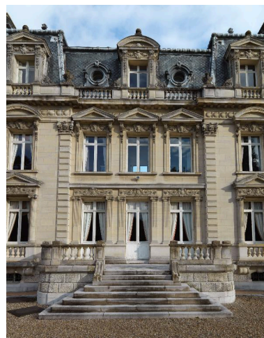
Travée centrale de la façade arrière du logis. Phot. Marie-Laure Monnehay-Vulliet IVR22_20128001361NUC2A
