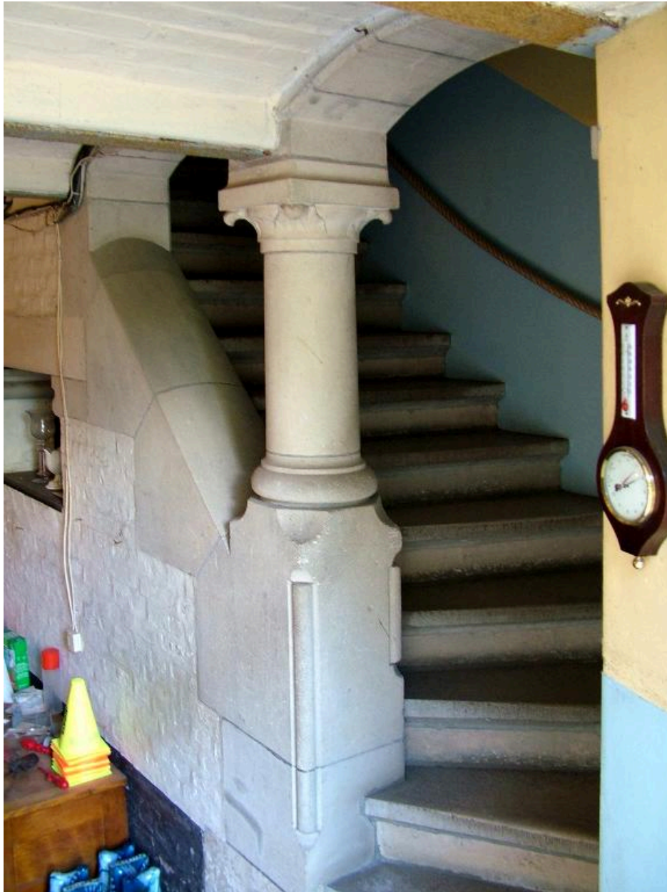
Escalier de service au sous-sol.
