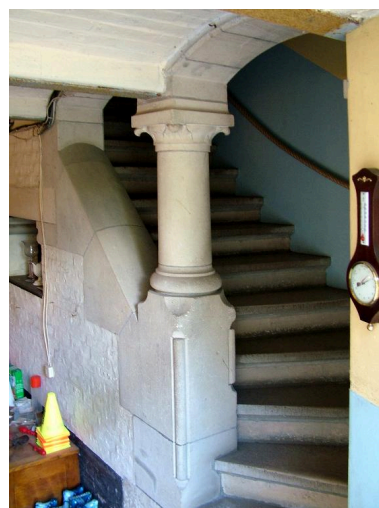
Escalier de service au sous-sol.
