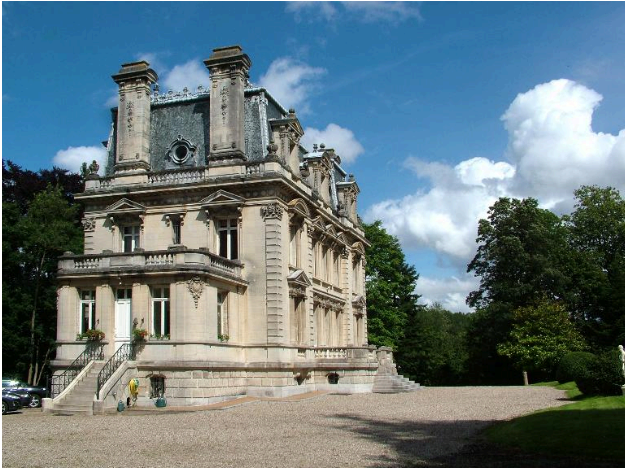
Elévations arrière et latérale du logis du côté du pavillon de la cuisine.
