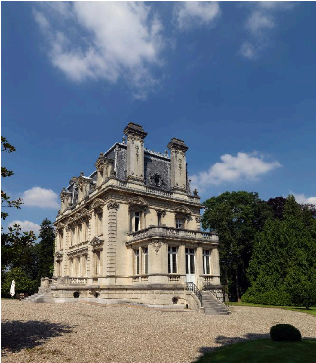
Elévations arrière et latérale du logis du côté du pavillon du jardin d'hiver.
