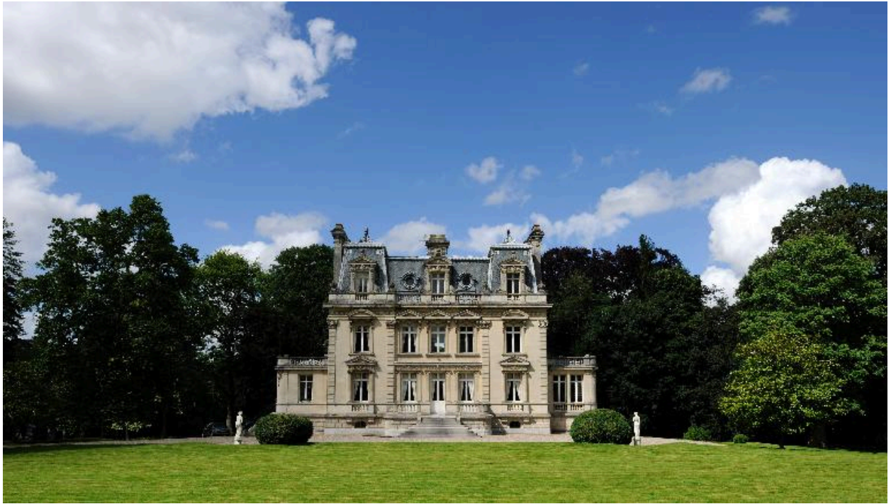
Façade arrière du logis sur parc.
