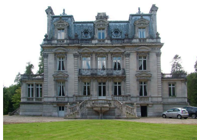
Façade antérieure du logis. Phot. Frédéric Fournis IVR22_20128015538NUCA
