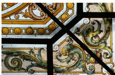
Jardin d'hiver, détail de la signature de la verrière en couverture : GAËTAN JEANNIN BILLANCOURT. Phot. Frédéric Fournis IVR22_20128015534NUCA
