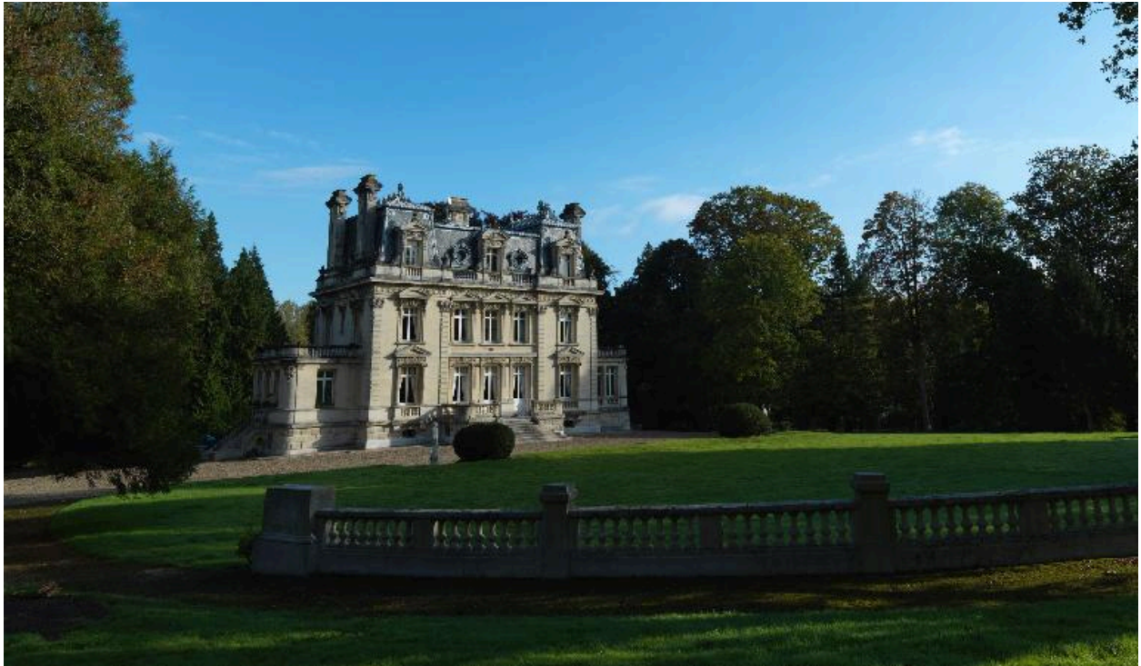
Façade arrière du logis depuis la balustrade.
