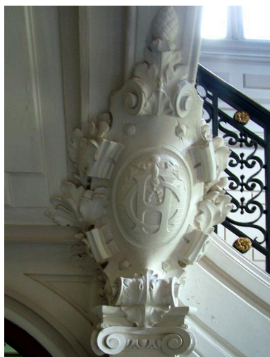
Escalier, cartouche sculpté sous le limon aux initiales entrelacées H et C (Hordequin et Carette). Phot. Frédéric Fournis IVR22_20128015527NUCA
