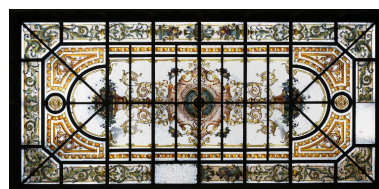
Jardin d'hiver, verrière en couverture. Phot. Marie-Laure Monnehay-Vulliet IVR22_20128001340NUC2A
