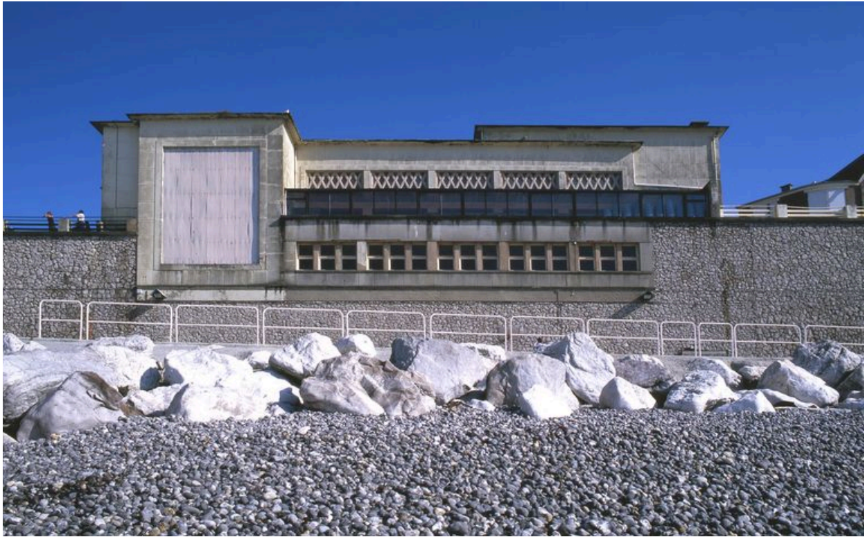
Vue générale, depuis la plage.
