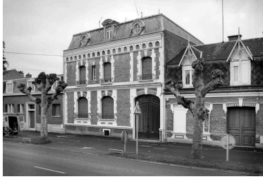
Vue de la façade sur rue. Phot. Frédéric Fournis IVR22_20030200127Z
