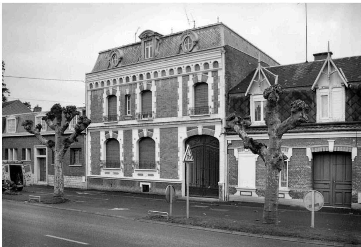
Vue de la façade sur rue.
