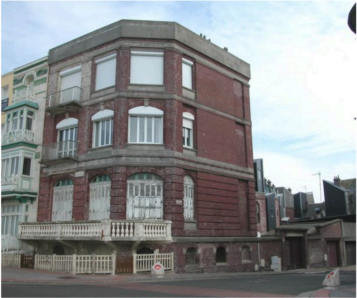
Vue d'ensemble depuis l'esplanade.
