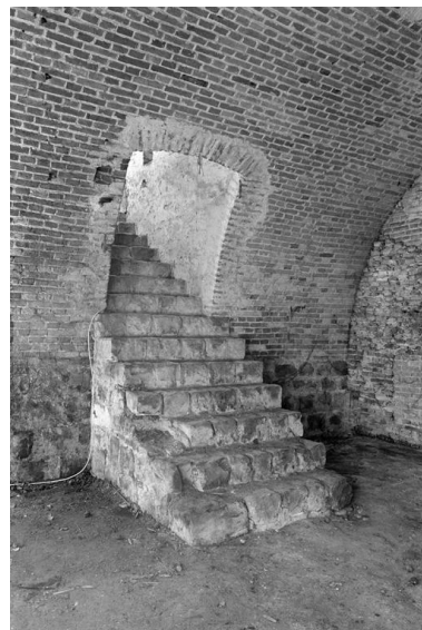
Vue de la descente de cave, reliant le rez-de-chaussée au 1er niveau de cave. Phot. Pierre-Yves Brest IVR22_19990202067Z
