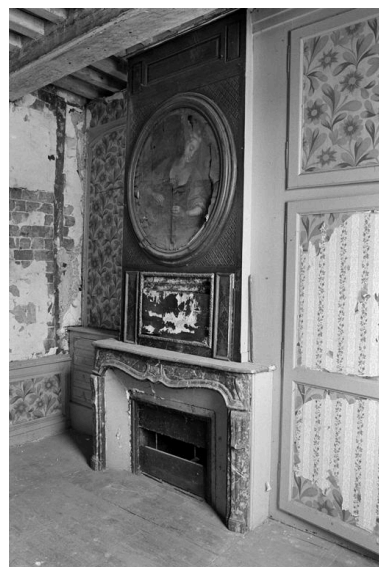
Vue du trumeau de cheminée du salon du rez-de-chaussée ; photographie prise en situation avant restauration de la pièce. Phot. Pierre-Yves Brest IVR22_19990202063Z
