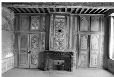
Vue de la chambre du 1er étage. Phot. Pierre-Yves Brest IVR22_19990202061Z
