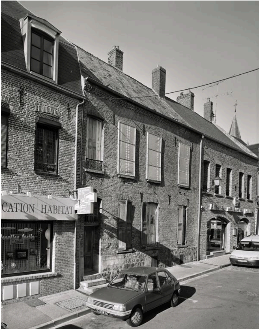
Vue de la façade sur rue.
