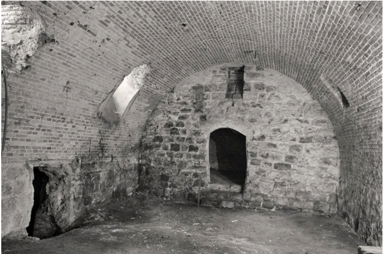
Vue générale du 1er niveau de cave, couvert d'une voûte en berceau plein-cintre en brique.
