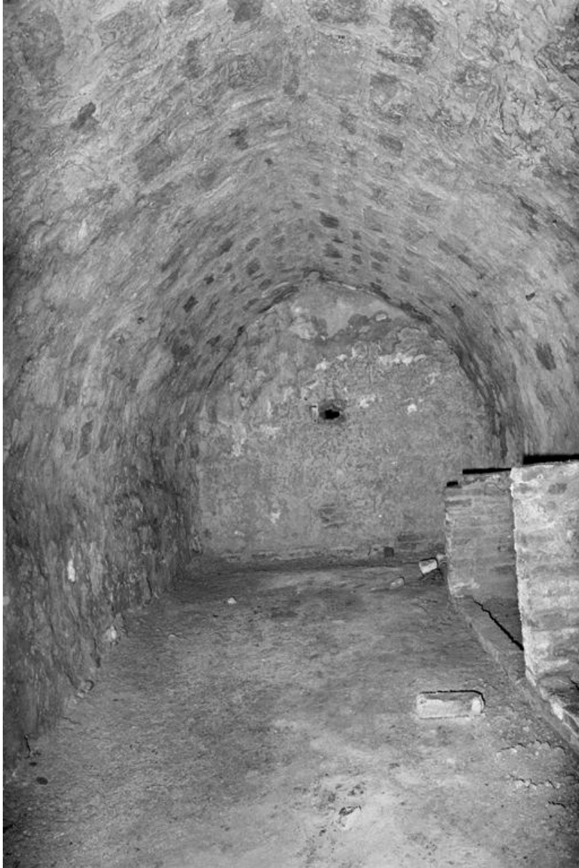
Vue générale du second niveau de cave, couvert d'une voûte en grès en berceau brisé.
