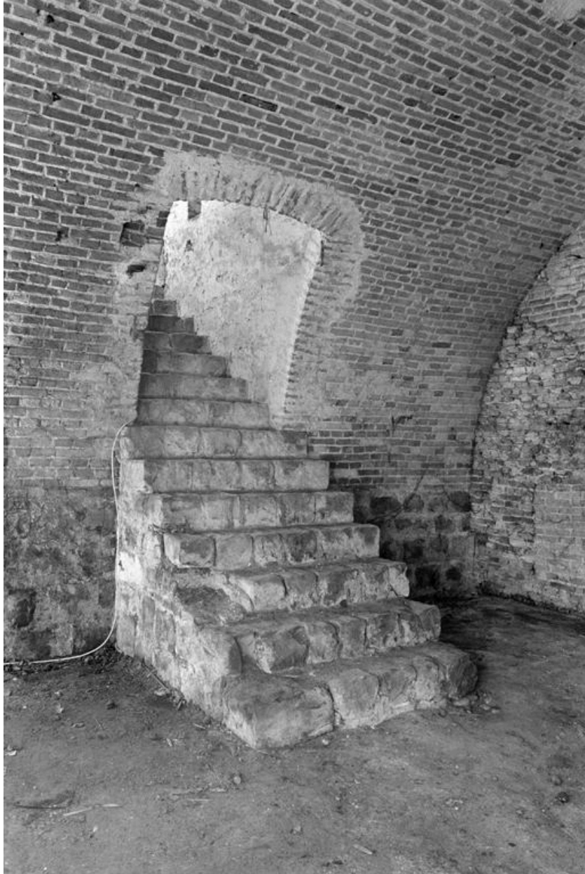
Vue de la descente de cave, reliant le rez-de-chaussée au 1er niveau de cave.
