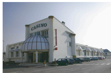
Vue d'ensemble sur la façade d'entrée et la façade sur mer, casino actuel. Phot. Elisabeth Justome IVR22_20058002611NUCA
