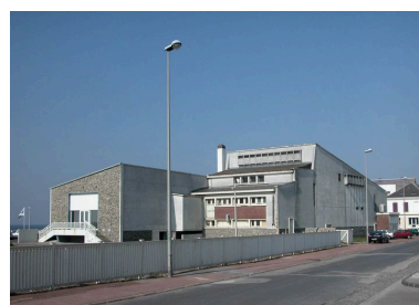
Vue d'ensemble, élévations postérieure et latérale, casino actuel. Phot. Elisabeth Justome IVR22_20058002612NUCA
