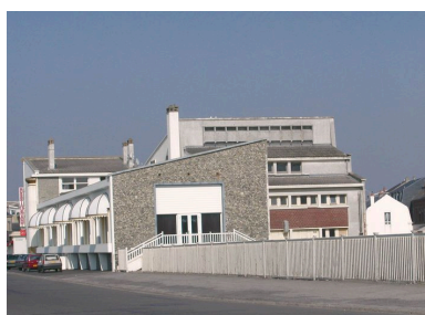
Elévation latérale, casino actuel. Phot. Elisabeth Justome IVR22_20058002610NUCA
