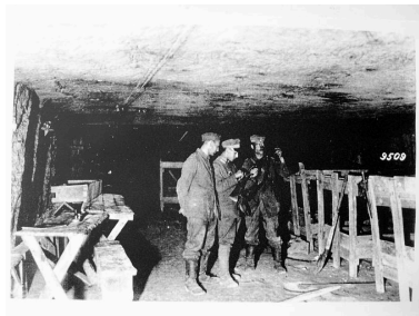
Vue intérieure de la carrière (coll. part). Phot. Inès Guérin IVR22_20030202286NUCAB
