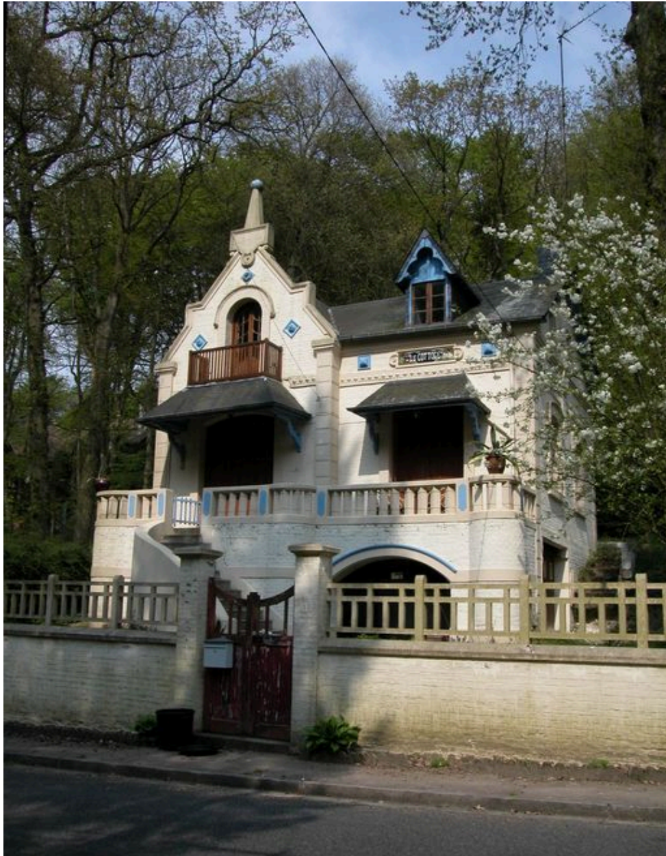
Vue de trois-quarts depuis la rue.
