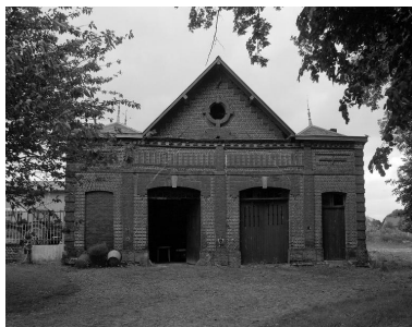
Garage et écurie. Phot. Irwin Leullier IVR22_20018000186X
