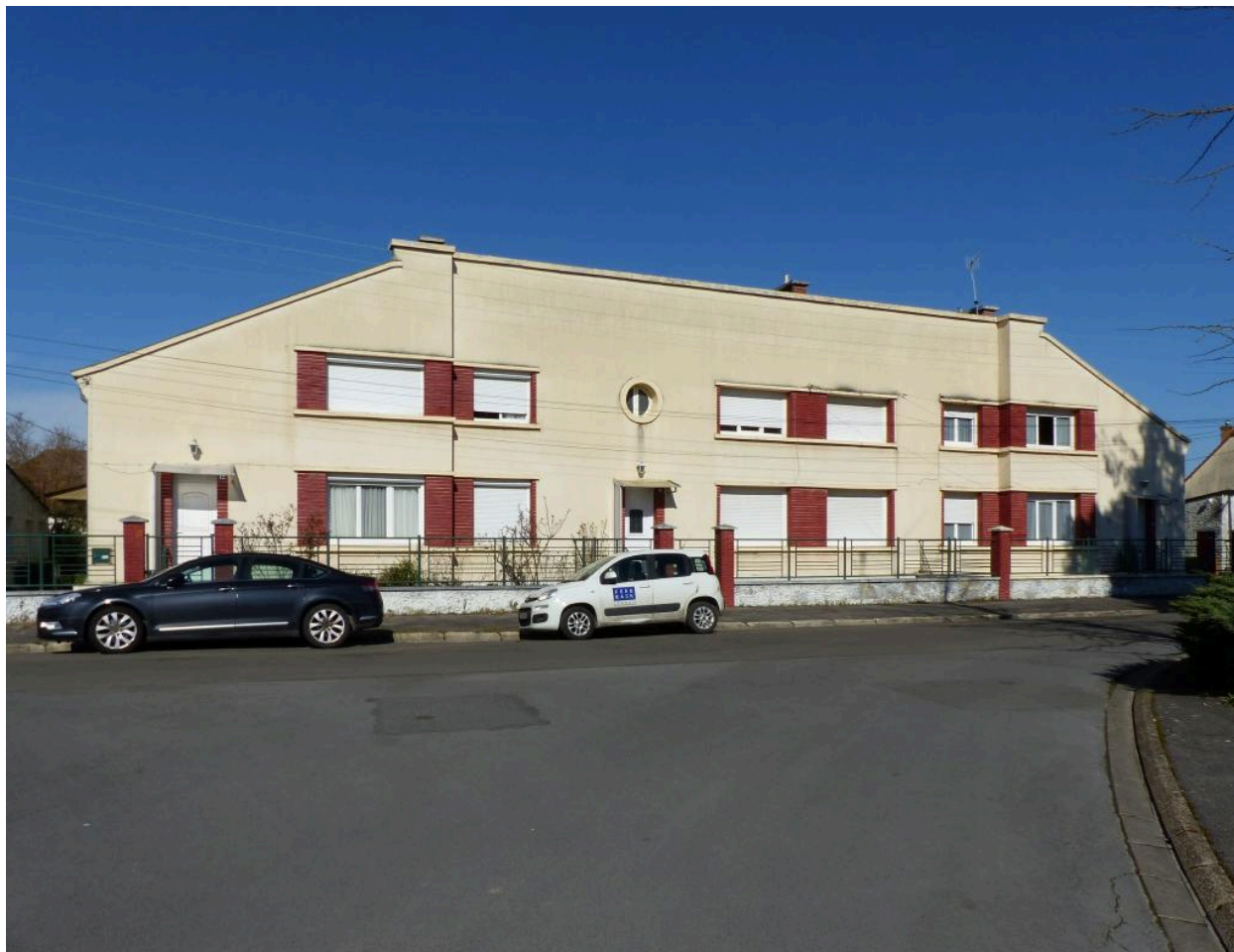
Maison à trois unités d'habitation, 8 à 12 rue Hélène-Boucher.
