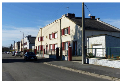
Groupes de logements, rive nord de la rue Hélène-Boucher. Phot. Isabelle Barbedor IVR32_20220205049NUCA
