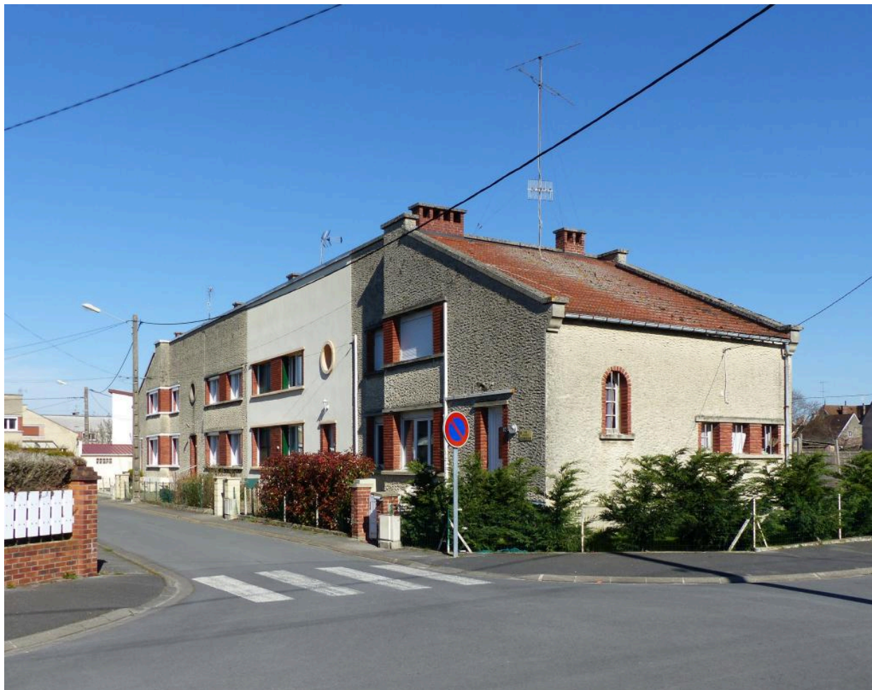
Maison à quatre unités d'habitation, 11 à 17 rue Georges-Clemenceau.
