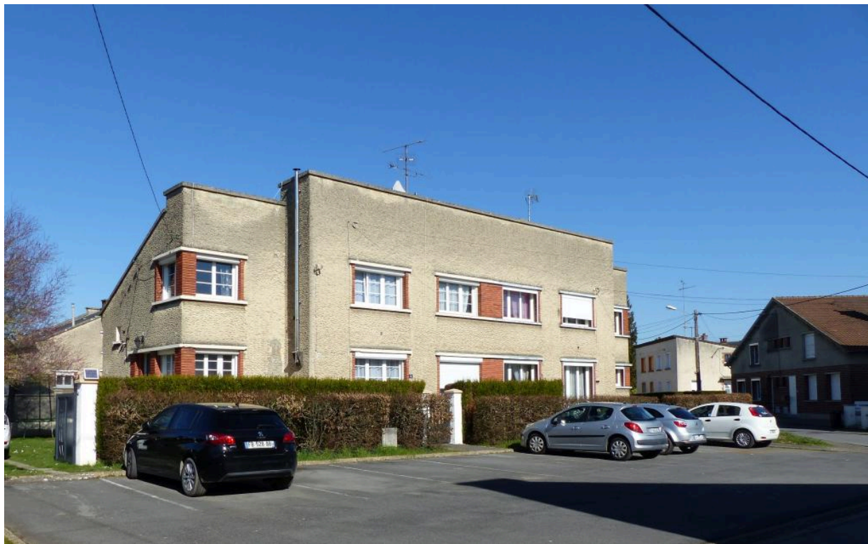
Maison à deux unités d'habitation, 2-4 rue Ernest-Lavis.
