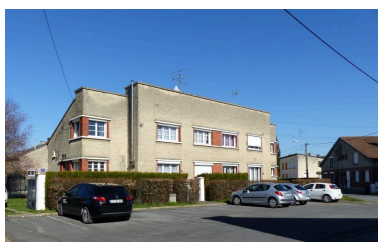
Maison à deux unités d'habitation, 2-4 rue Ernest-Lavis. Phot. Isabelle Barbedor IVR32_20220205041NUCA
