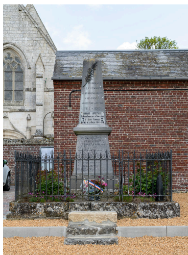
Monument aux morts de Saint-André-Farivillers, signé Boussard, entrée du cimetière, vue prise depuis l'ouest. Phot. Marc Kérignard IVR32_20236000674NUCA
