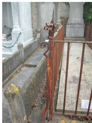
Détail de la grille. Phot. Laurent Nicolas IVR22_20058002211NUCA
