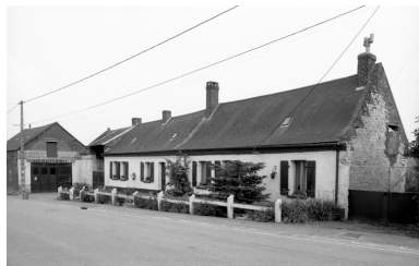
Vue d'ensemble de l'élévation sur rue. Phot. Thierry Lefébure IVR22_19920201089Z
