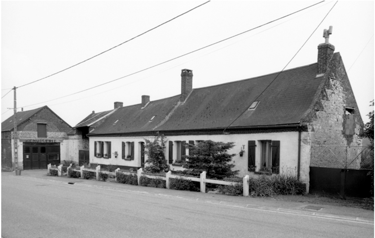
Vue d'ensemble de l'élévation sur rue.
