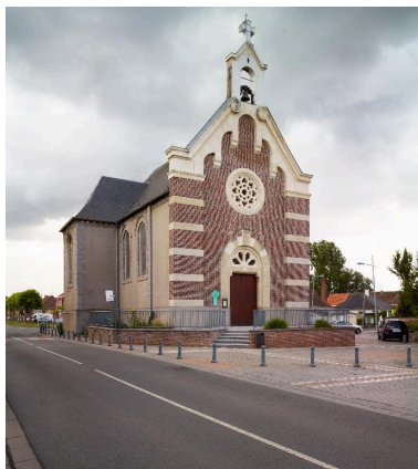
Vue générale. Phot. Pierre Thibaut IVR31_20155901401NUCA
