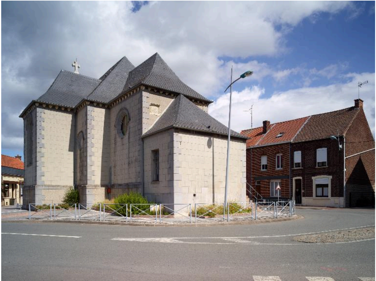
Vue générale extérieure de trois quarts depuis l'abside.
