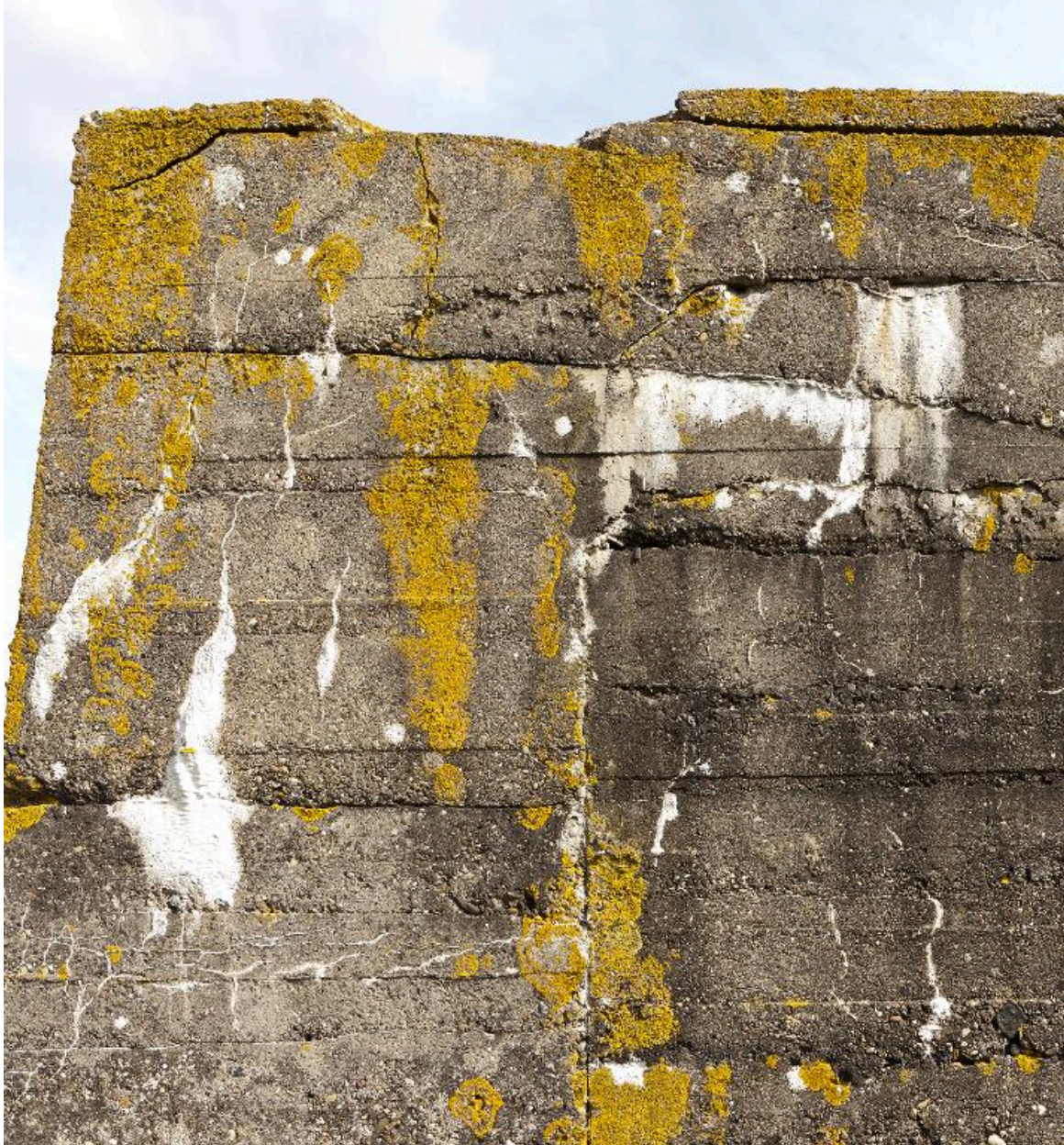
Raccord de plans de coulée sur l'élévation sud
