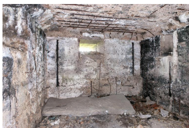
Vue intérieure Phot. Pierre Thibaut IVR32_20165900960NUCA
