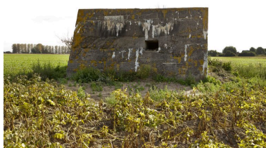
Elévation ouest Phot. Jean-Marc Ramette IVR31_20145904567NUCA
