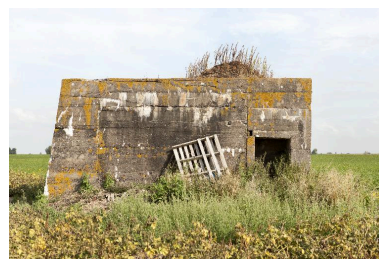
Elévation sud. Entrée Phot. Jean-Marc Ramette IVR31_20145904565NUCA
