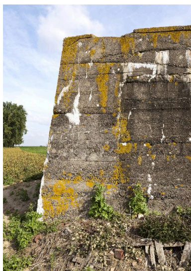
Empatement de l'élévation ouest, vers le nord Phot. Jean-Marc Ramette IVR31_20145904571NUCA
