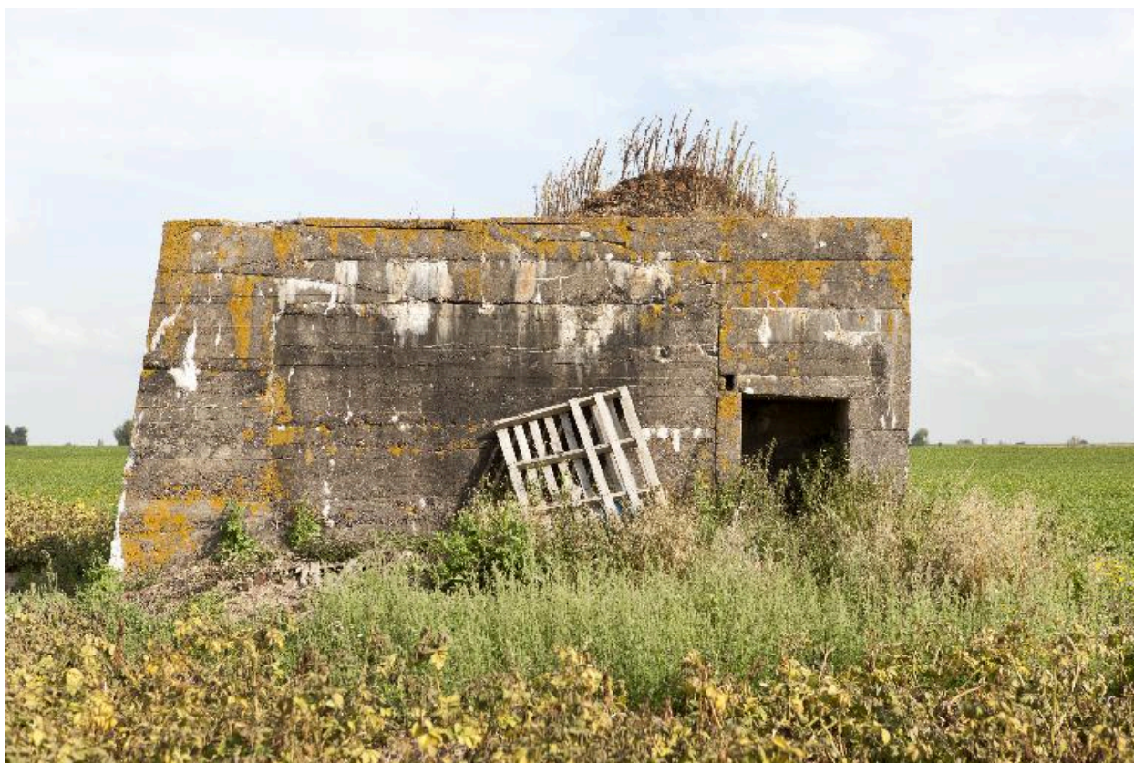
Elévation sud. Entrée
