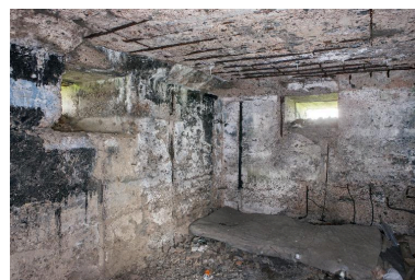
Vue intérieure Phot. Pierre Thibaut IVR32_20165900959NUCA
