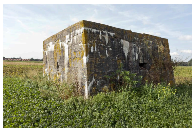
Vue vers le sud-ouest Phot. Jean-Marc Ramette IVR31_20145904569NUCA
