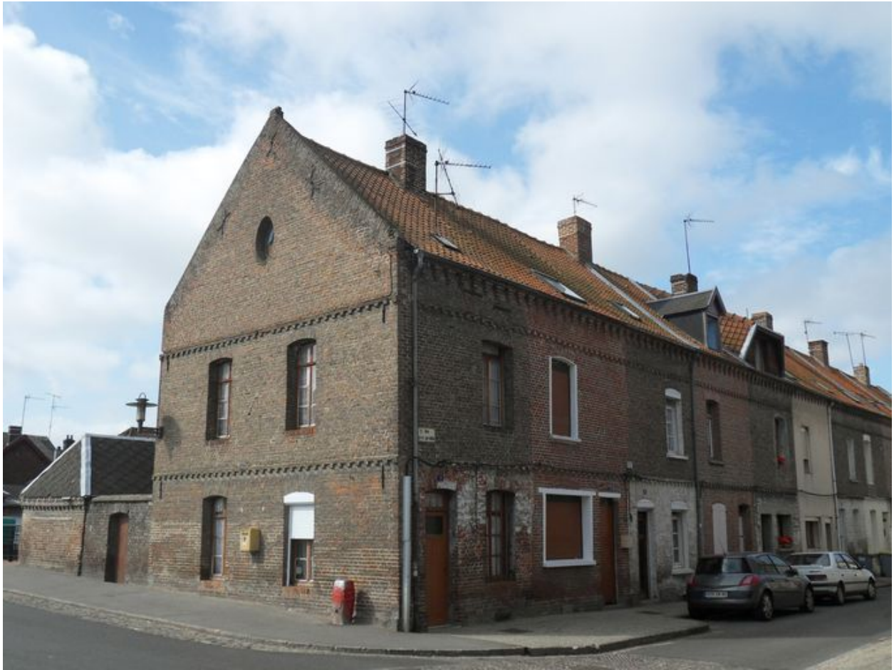
Les logements de la rive sud, construits en 1864.
