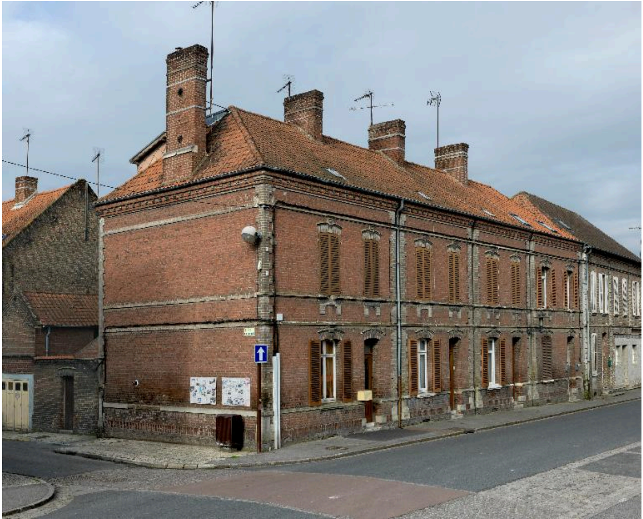
Les quatre logements de contremaîtres, construits en 1886, chaussée Brunehaut.
