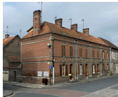
Les quatre logements de contremaîtres, construits en 1886, chaussée Brunehaut. Phot. Thierry Lefébure IVR22_20128000867NUC2A
