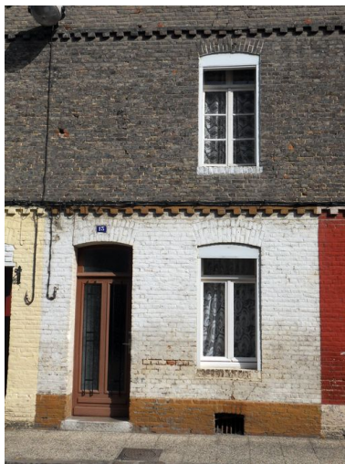
Détail de la façade d'un logement construit en 1864. Phot. Isabelle Barbedor IVR22_20108001633NUCA
