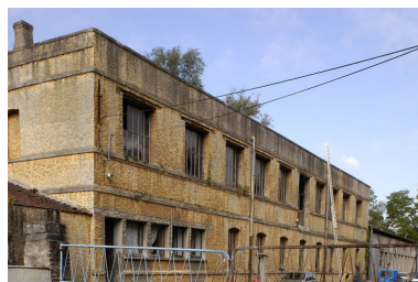
Vue générale sur cour du moulin à foulon.
