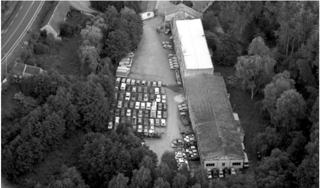
Vue aérienne de l'usine en 1993.
