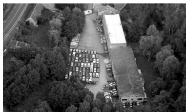
Vue aérienne de l'usine en 1993.
