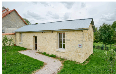
Musée de Vassogne, maison semi-provisoire de type "Puchot", 1919, vue nord-ouest. Phot. Thierry Lefébure IVR32_20230200136NUCA
