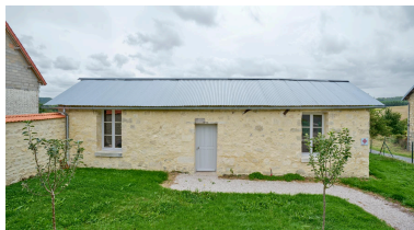
Musée de Vassogne, maison semi-provisoire de type "Puchot", 1919, vue nord. Phot. Thierry Lefébure IVR32_20230200137NUCA
