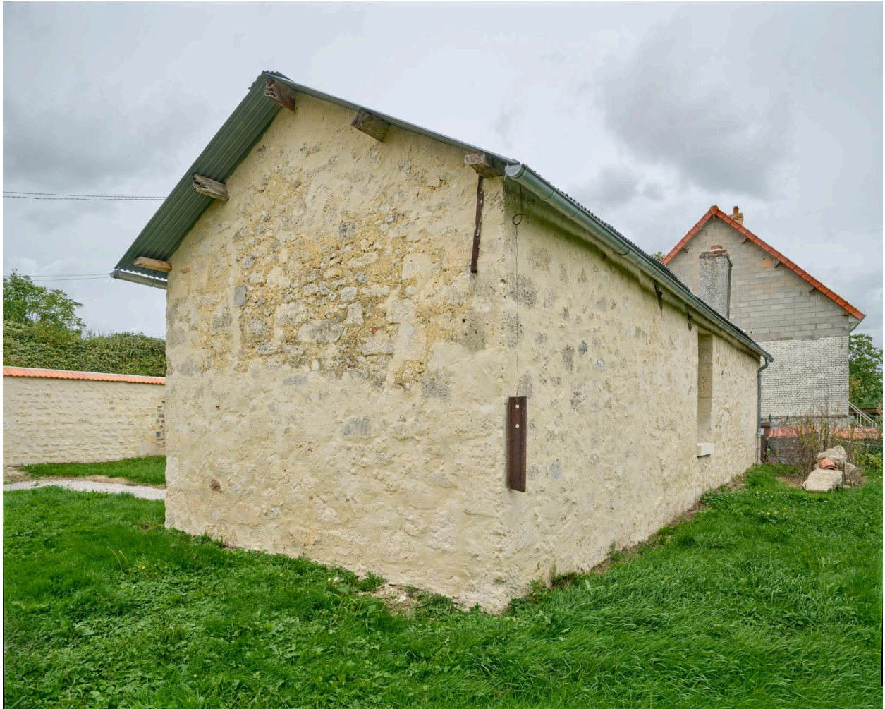
Musée de Vassogne, maison semi-provisoire de type "Puchot", 1919, vue sud-ouest.
