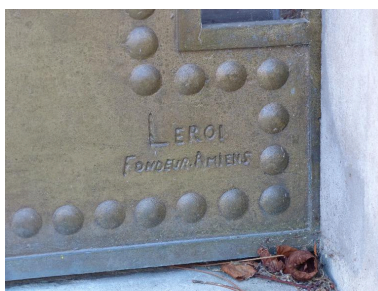
Vue de détail de la signature du fondeur Leroi d'Amiens. Phot. Isabelle Barbedor IVR22_20168006404NUCA
