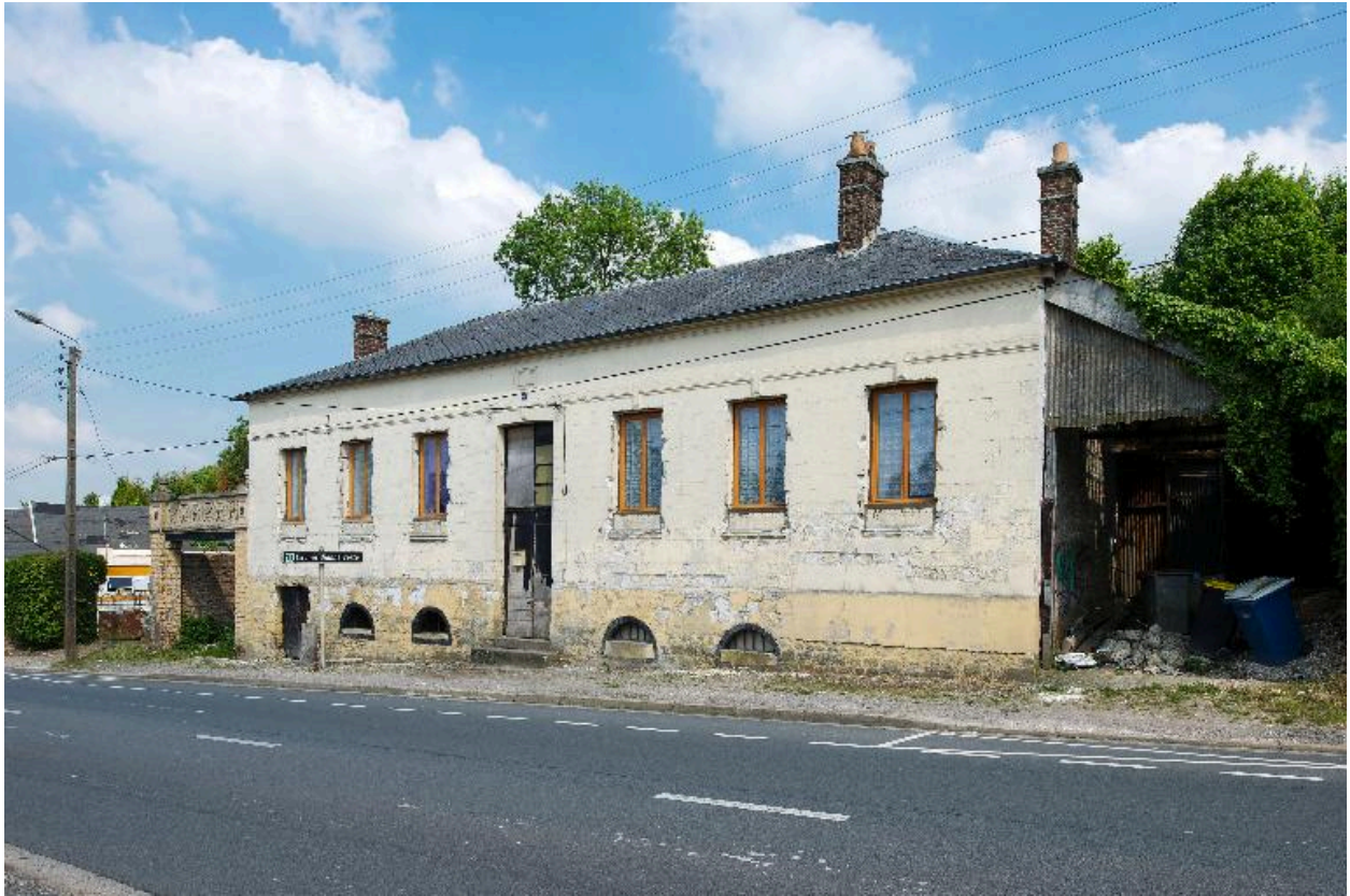
Façade sur rue, vue d'ensemble de trois-quarts.
