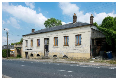
Façade sur rue, vue d'ensemble de trois-quarts. Phot. Thierry Lefébure IVR22_20138000219NUC2A
