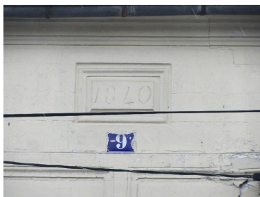
Détail de la date portée. Phot. Bertrand Fournier IVR22_20138015822NUC2A
