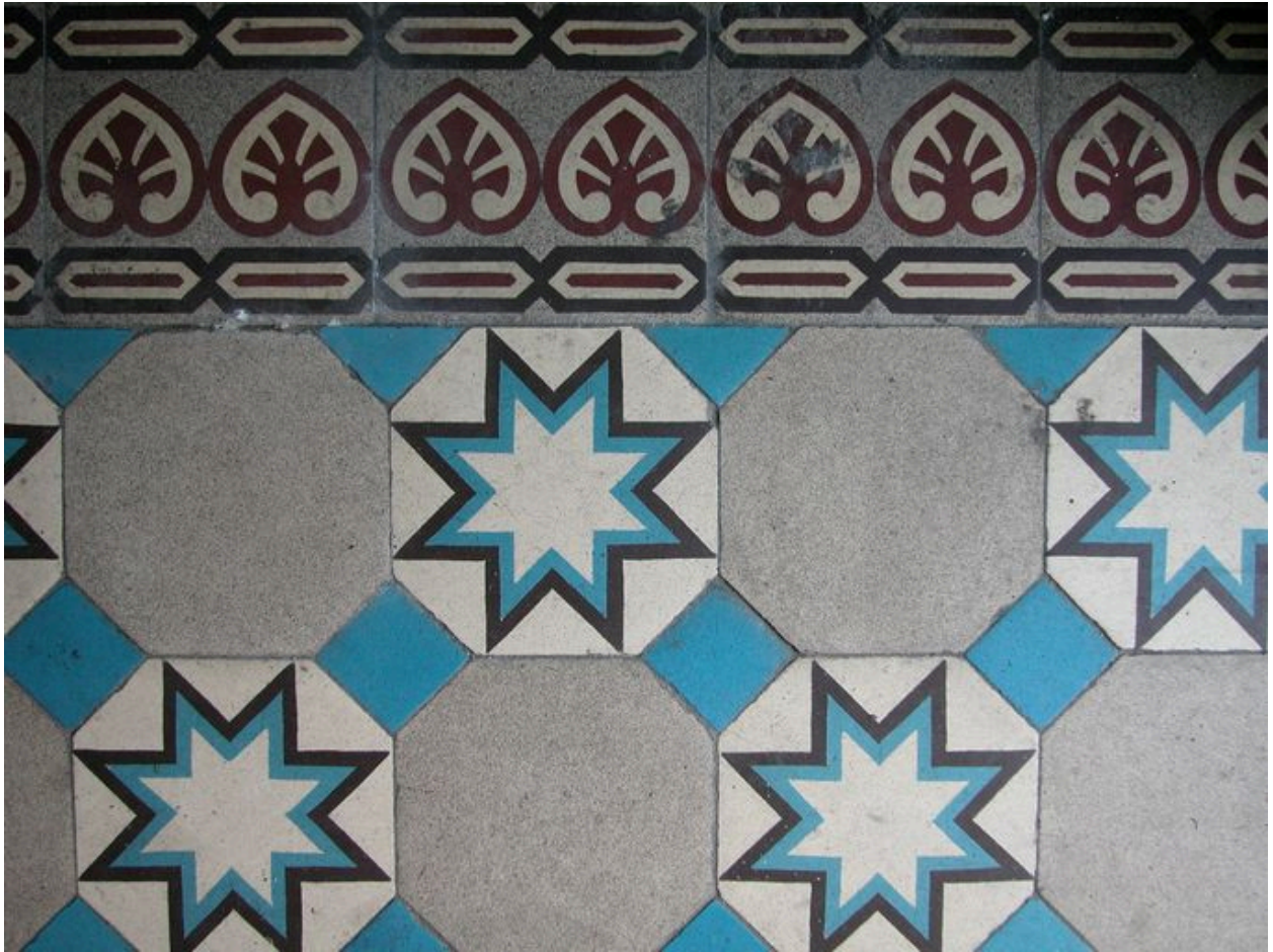
Détail des carreaux de sol en grès cérame du vestibule d'entrée.
