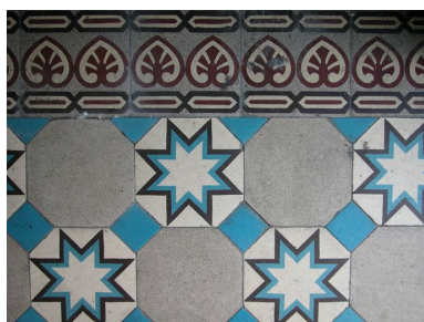
Détail des carreaux de sol en grès cérame du vestibule d'entrée.
