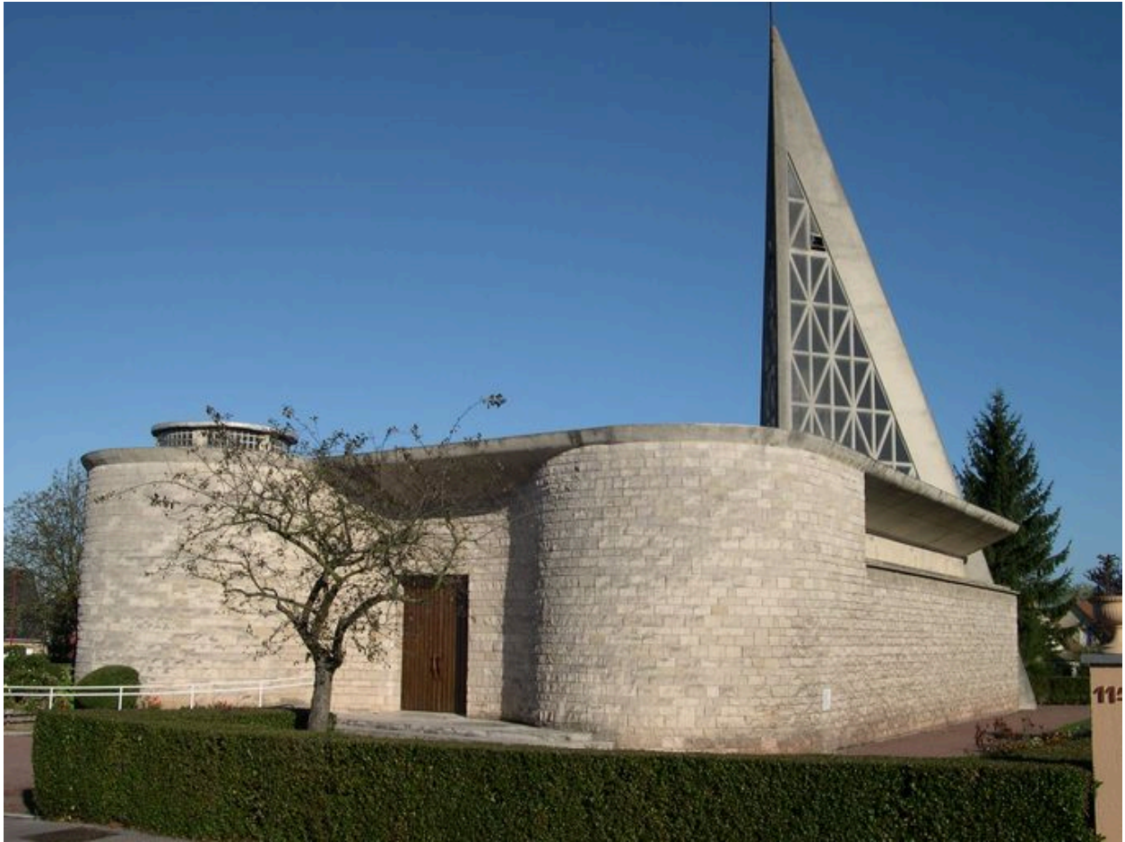
Vue depuis le sud-est.
