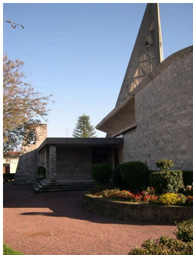
Vue depuis le sud-ouest. Phot. Isabelle Barbedor IVR22_20048010455NUCA
