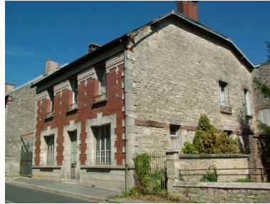
Vue latérale. Phot. Inès Guérin IVR22_20030202495NUCA
