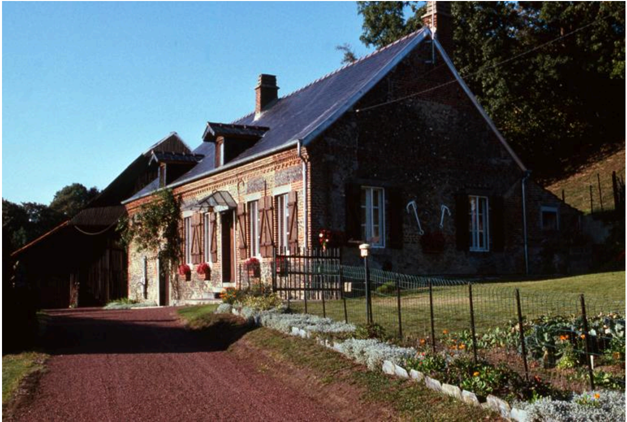
Vue d'ensemble des bâtiments, depuis le sud.
