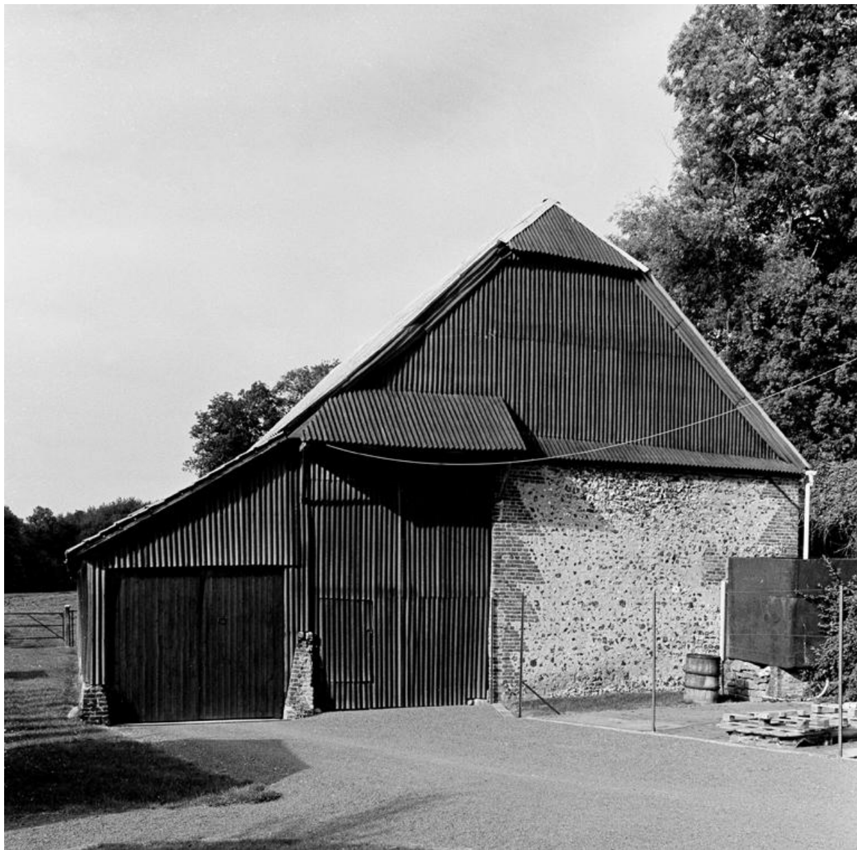
Vue de l'élévation sud de la grange.
