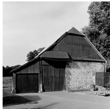
Vue de l'élévation sud de la grange. Phot. Christiane Riboulleau IVR22_19900202501Z
