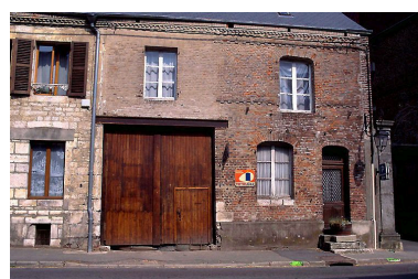
Vue de l'élévation sur rue du n°6. Phot. Martine Plouvier IVR22_19980203509ZA
