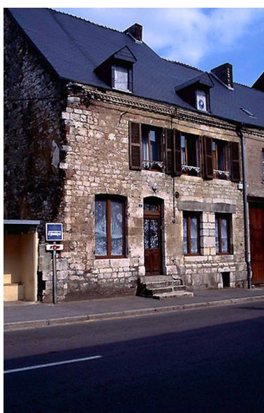
Vue de l'élévation sur rue du n°4. Phot. Martine Plouvier IVR22_19980203511ZA
