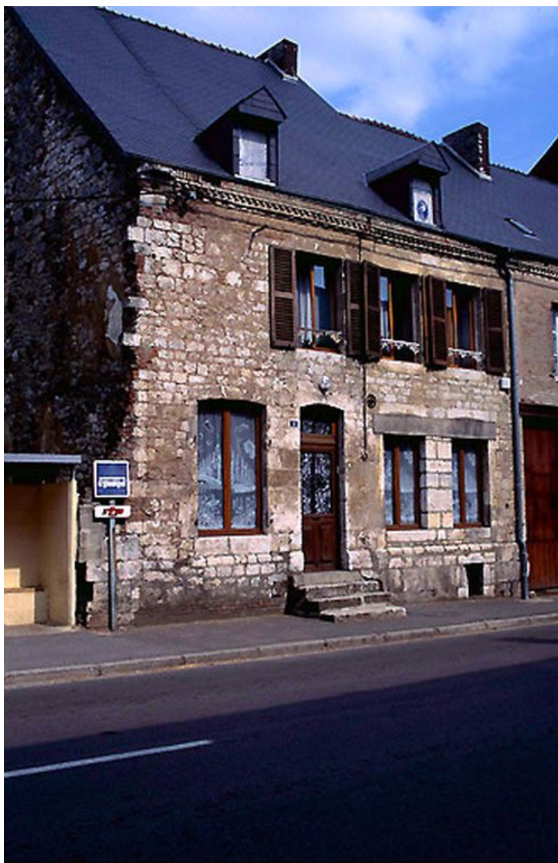
Vue de l'élévation sur rue du n°4.
