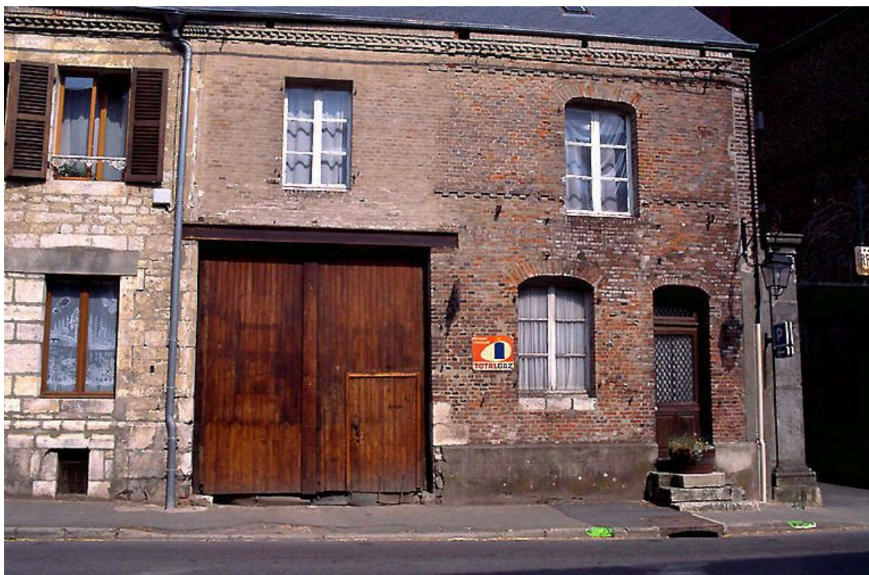
Vue de l'élévation sur rue du n°6.
