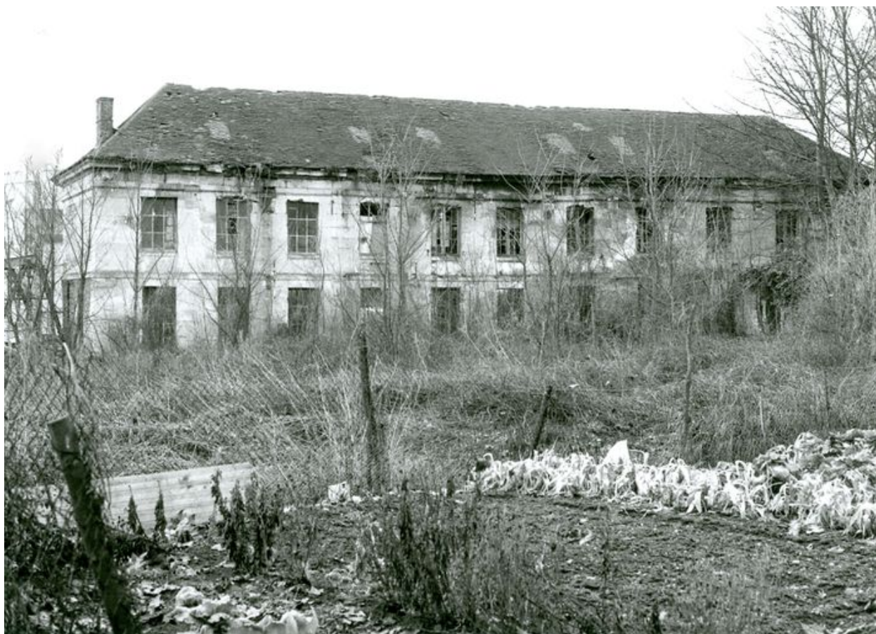
Usine III : Vestiges de bâtiments dépendants du moulin du château vers 1970 (AC Villers-Saint-Paul).
