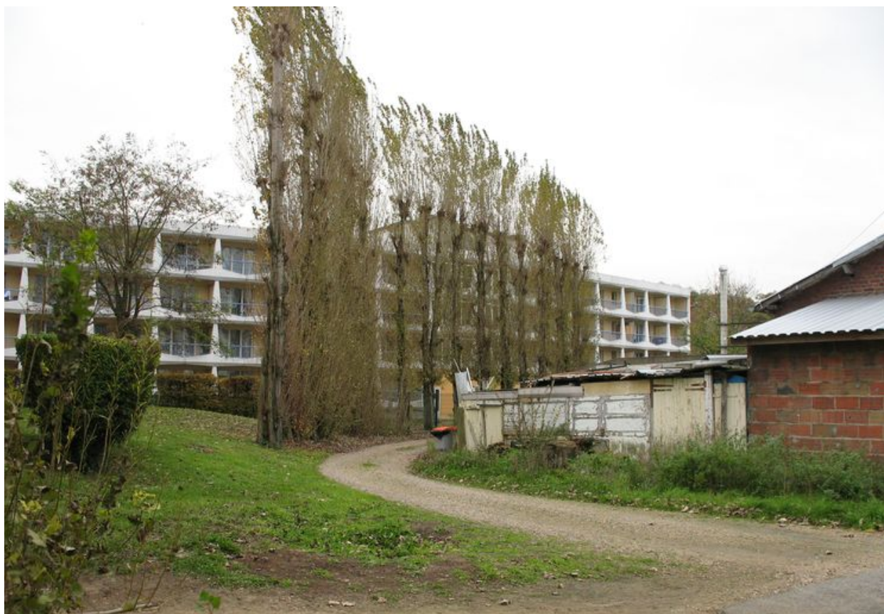
Usine II : bâtiment construit à l'emplacement du moulin et courbe du chemin suivant l'ancien tracé de la Petite Brèche.
