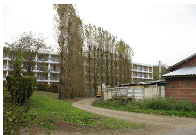
Usine II : bâtiment construit à l'emplacement du moulin et courbe du chemin suivant l'ancien tracé de la Petite Brèche. Phot. Clarisse Lorieux IVR22_20066005065NUCA
