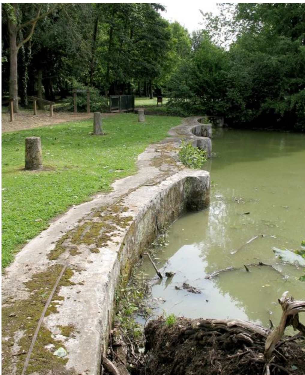
Usine III : Le déversoir en pierre qui permettait d'alimenter les bras d'eau de la Brèche en amont du moulin du château est construit avant 1810.
