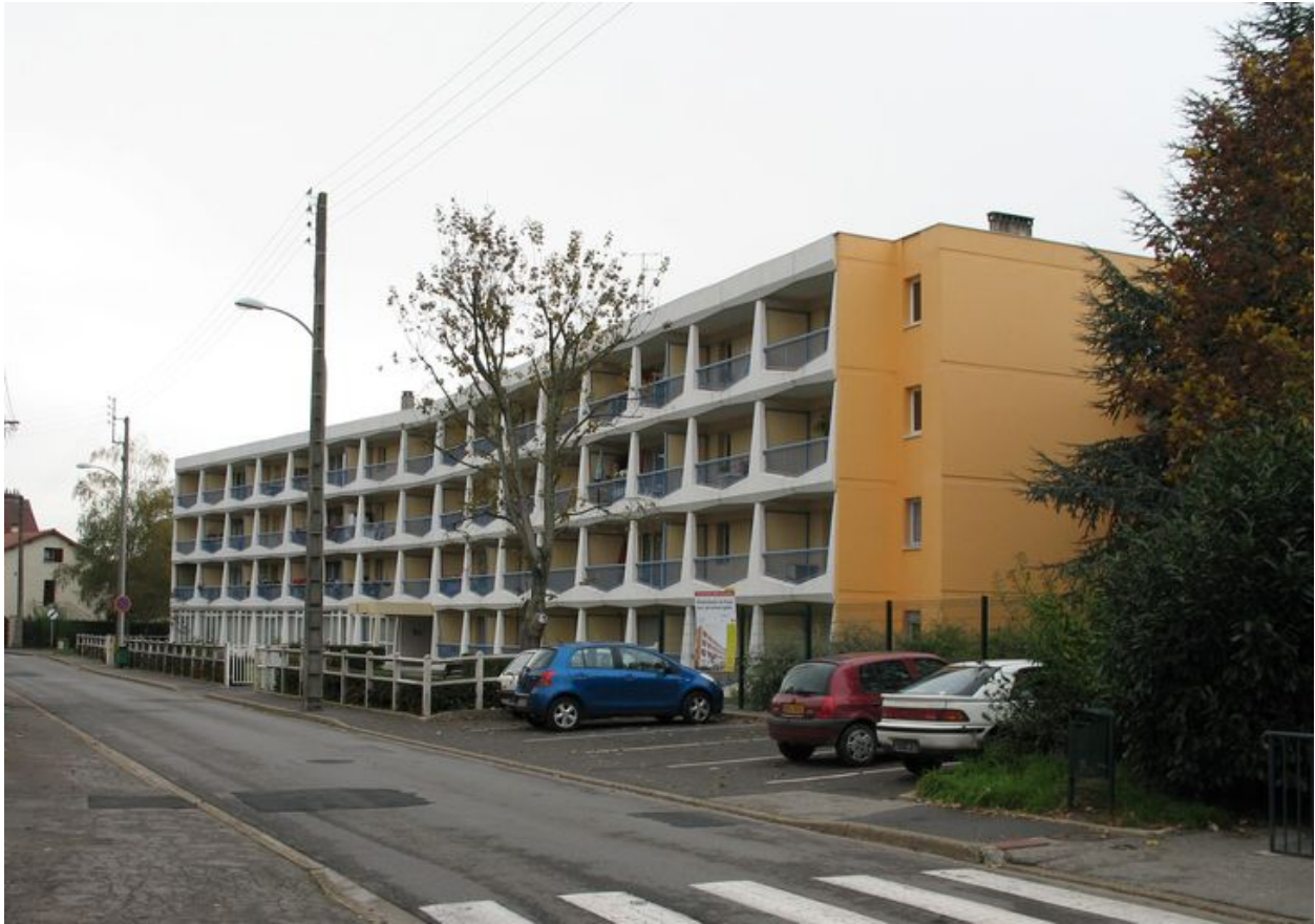
Usine II : emplacement de l'ancien moulin de Franchemont.
