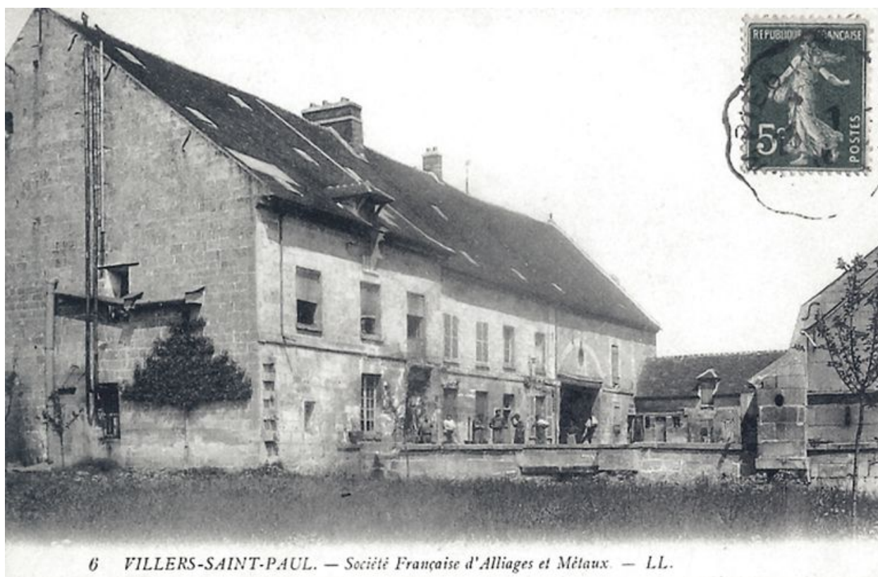
Usine IV : La ferme de la Barrière occupée par la société d'alliages, après 1906 (AC Villers-Saint-Paul).
