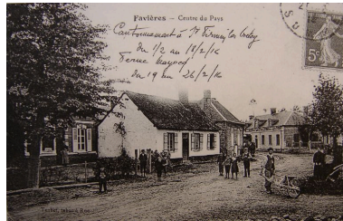
Vue du centre-village au début du 20e siècle. Phot. Inès Guérin IVR22_20078005800NUCAB
