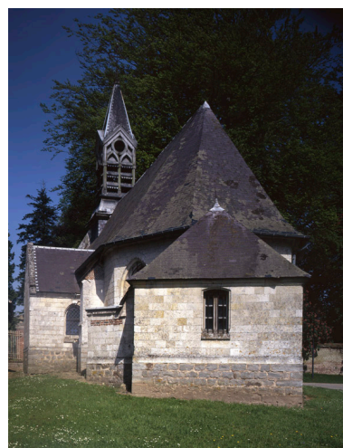
Vue du chevet. Phot. Irwin Leullier IVR22_19988000583VA
