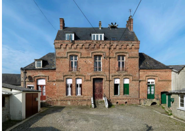
Vue générale depuis la cour. Phot. Frédéric-Nicolas Kocourek IVR22_20148000509NUC2A
