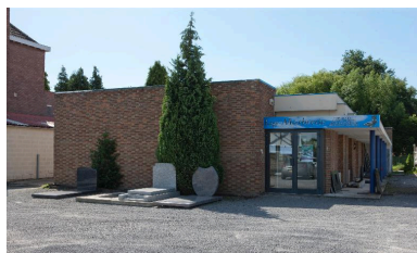
Vue générale. Phot. Pierre Thibaut IVR31_20145903229NUCA
