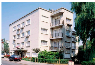
Immeuble Gounod, bloc 2 de l'îlot. Phot. Thierry Petitberghien IVR31_19945901161ZA
